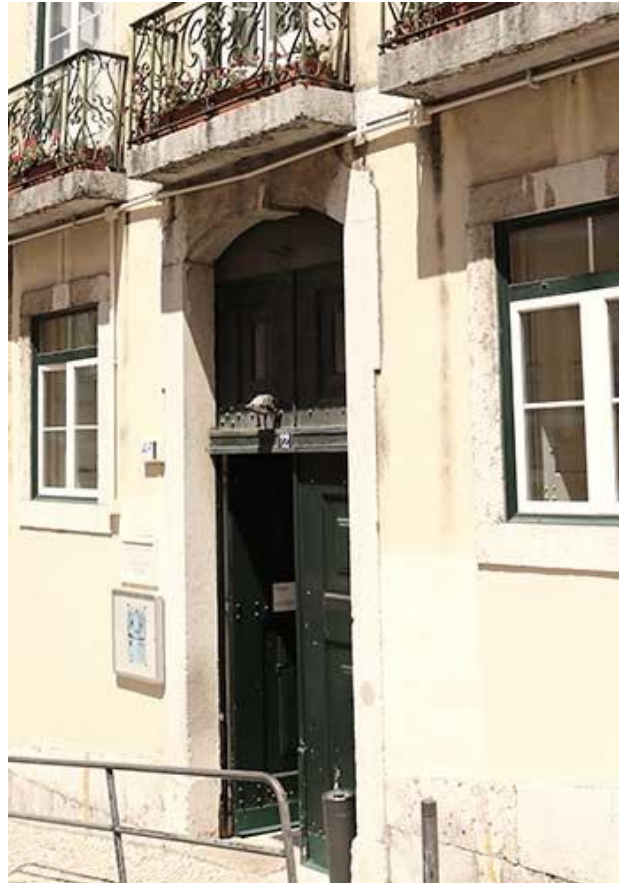
Figura 1. Entrada principal para o edifício da EADCN
