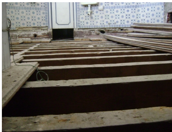
Figura 7.10: Vista geral das vigas do pavimento
