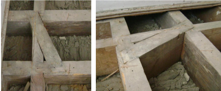
Figura 4.6: Pormenor de travamento do pavimento
