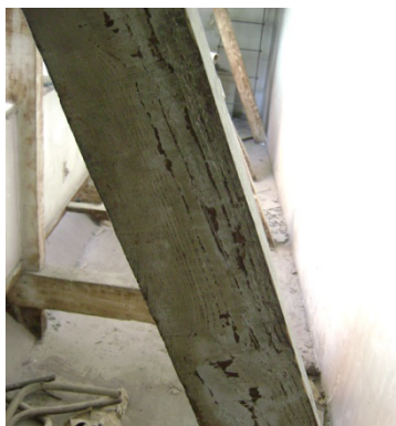
Figura 7.5: Pintura de cal na perna de asna 1 da cobertura do lanternim
