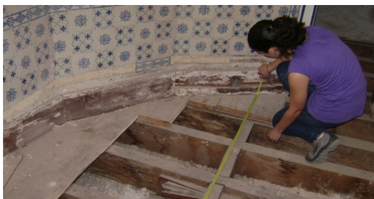
Figura 5.2: Medição do comprimento das vigas do pavimento
