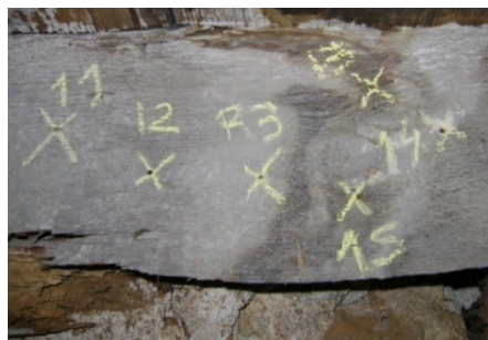
Figura 5.32: Localização dos ensaios realizados no Elemento 4 da cobertura dos arrumos (Face orientada para Sudeste)
