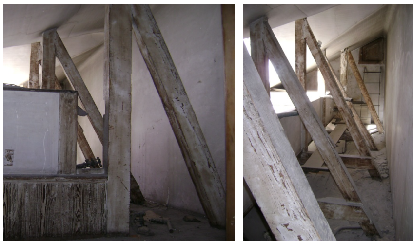
Figura 4.10: Vista global da cobertura dos arrumos
