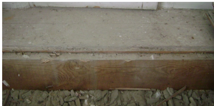
Figura 7.3: Viga 1: Canto, Topos e face inacessível
