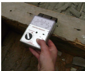
Figura 5.3: Utilização do humidímetro de contacto em viga do pavimento
