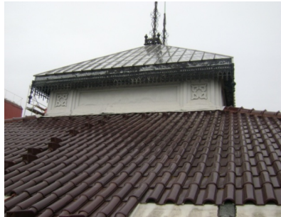
Figura 4.9: Pormenor da cobertura: telhas
