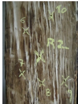
Figura 5.36: Localização dos ensaios realizados no Elemento 1 da cobertura do lanternim (Face orientada para Noroeste)
