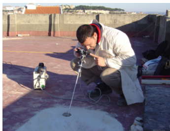
Figura 3.14: Observação do interior de um pavimento com o boroscópio ( in Observação boroscópica de cavidade e fendas)
