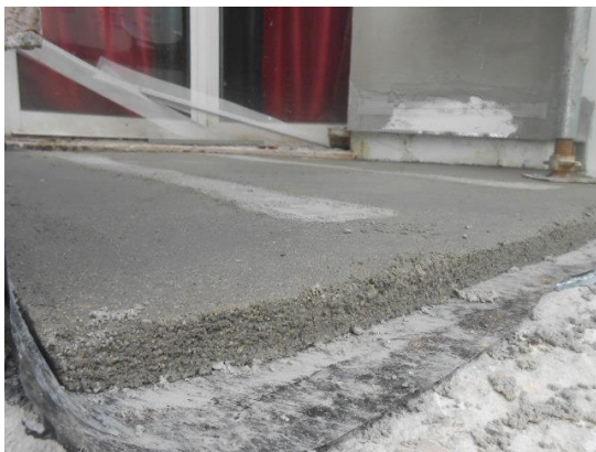
Figura 33 - Camada de regularização do pavimento das varandas
