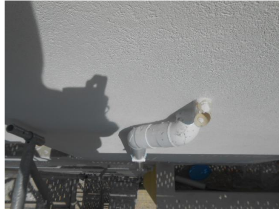
Figura 48 - Pormenor de topo de tubo de queda de águas pluviais
