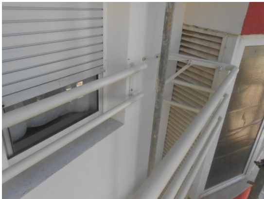
Figura 42 - Exemplo de guarda metálica colocada após reparação
