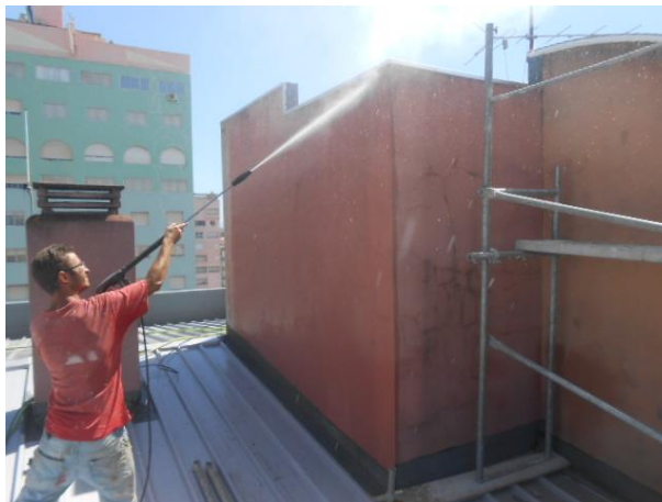
Figura 31 - Limpeza da casa das máquinas para posterior pintura
