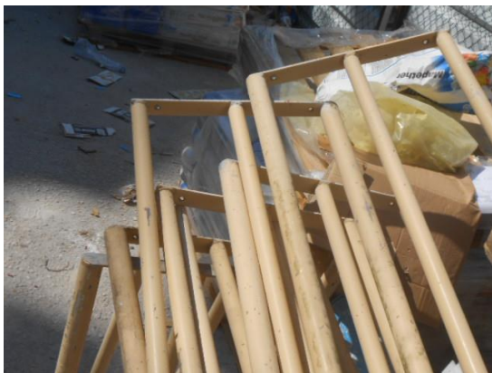
Figura 36 - Armazenamento em estaleiro das guardas metálicas após tratamento em oficina
