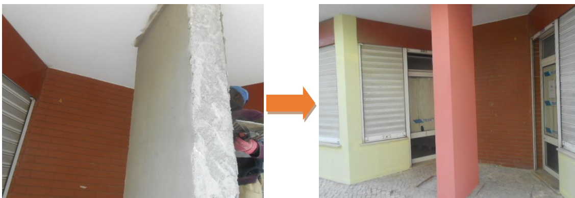
Figura 17 - Exemplo de aplicação de primário de pintura num pilar do piso térreo
