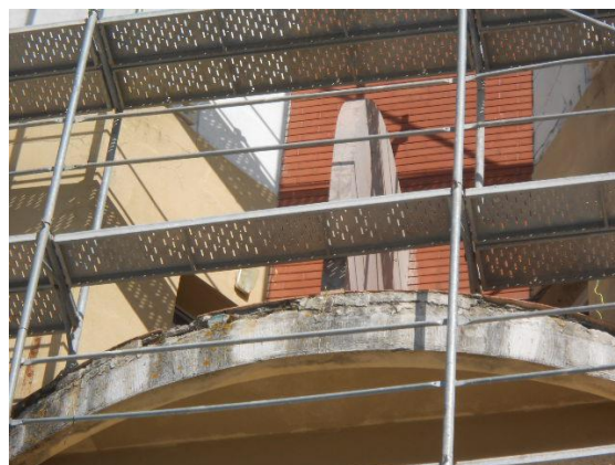
Figura 15 - Pormenor de varanda do quinto piso
