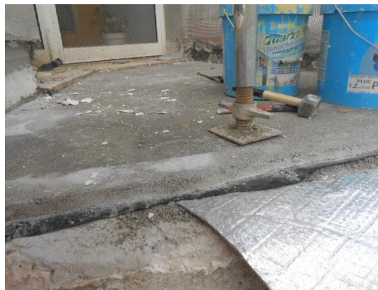
Figura 34 - Membrana de impermeabilização aplicada nas varandas
