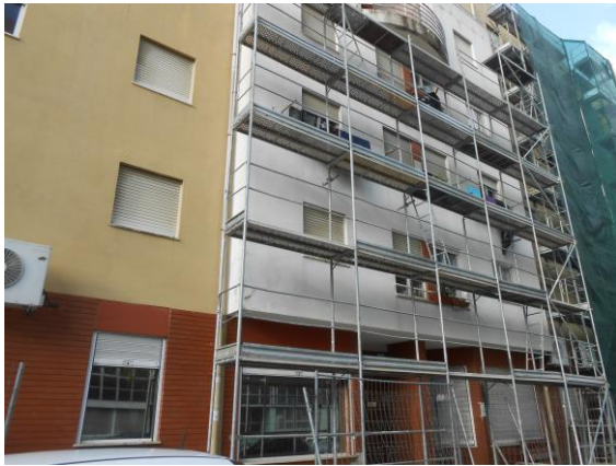
Foto 3. Montagem de andaimes na frente de obra
