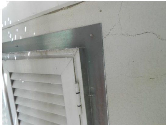
Figura 6 - Pormenor de chpa utilizada para vencer o acréscimo de espessura da parede
