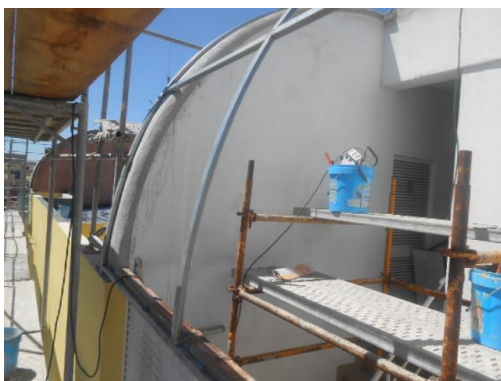
Figura 38 – Clarabóia pronta para aplicação do painel de policarbonato alveolar
