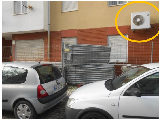
Figura 13 - Pormenor de um equipamento de ar condicionado que é necessário remover
