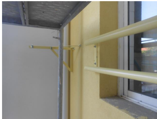
Figura 43 - Exemplo de estendal colocado após reparação
