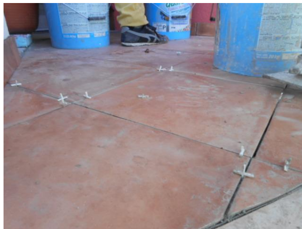
Figura 35 - Colocação dos mosaicos no pavimento das varandas
