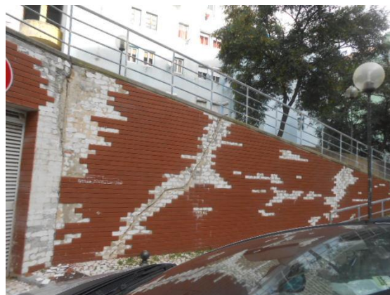
Figura 11 - Remoção de ladrilhos soltos na rampa junto ao lote 6
