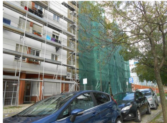
Foto 4. Montagem de andaimes na frente de obra
