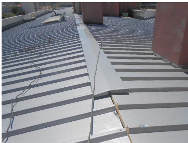
Figura 64 - Aplicação da nova chapa tipo Sandwich
