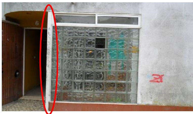
Figura 19 - Localização de um pilar metálico alvo de intervenção
