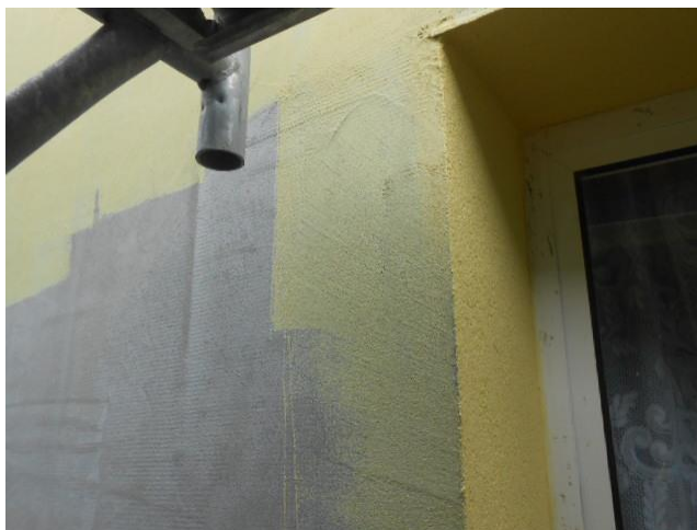
Figura 29 - Exemplo de aplicação de primário de pintura por cima da argamassa
