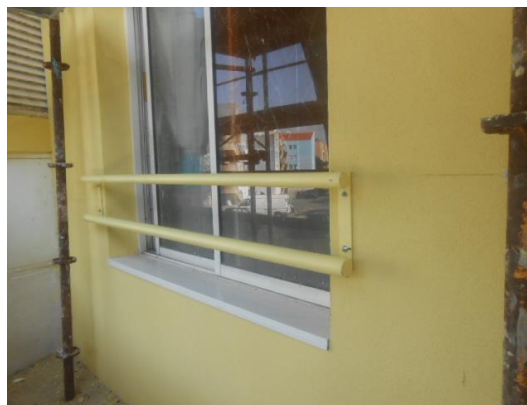
Figura 8 - Exemplo de guarda metálica numa janela
