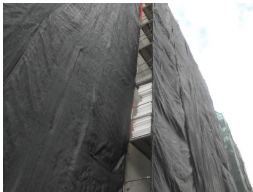
Figura 4 - Andaimos com colocação de rede tipo mosquiteira
