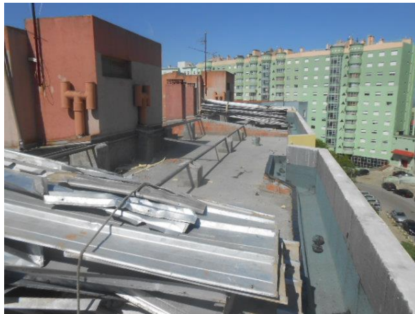
Figura 62 - Remoção da chapa existente na cobertura
