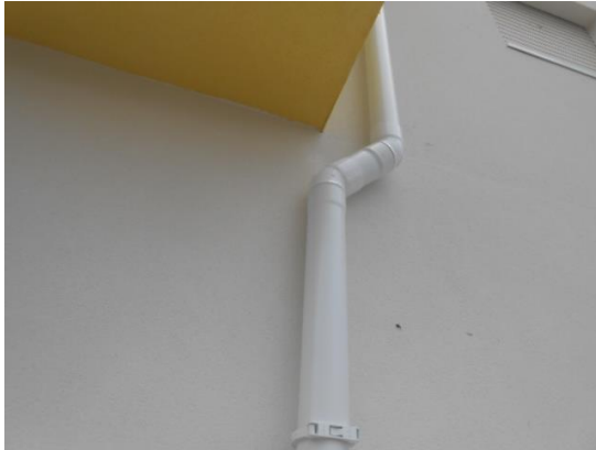
Figura 47 - Pormenor de curva do tubo de queda de águas pluviais
