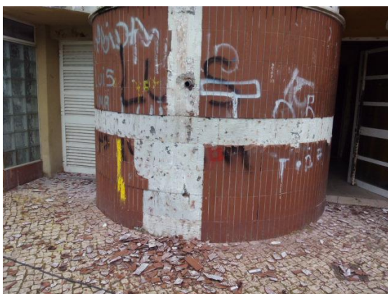
Figura 10 - Remoção de ladrilhos no núcleo exterior de escadas do piso térreo
