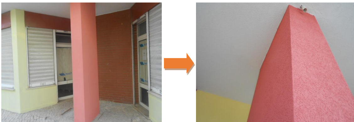
Figura 18 - Exemplo de aplicação de revestimento decorativo num pilar do piso térreo
