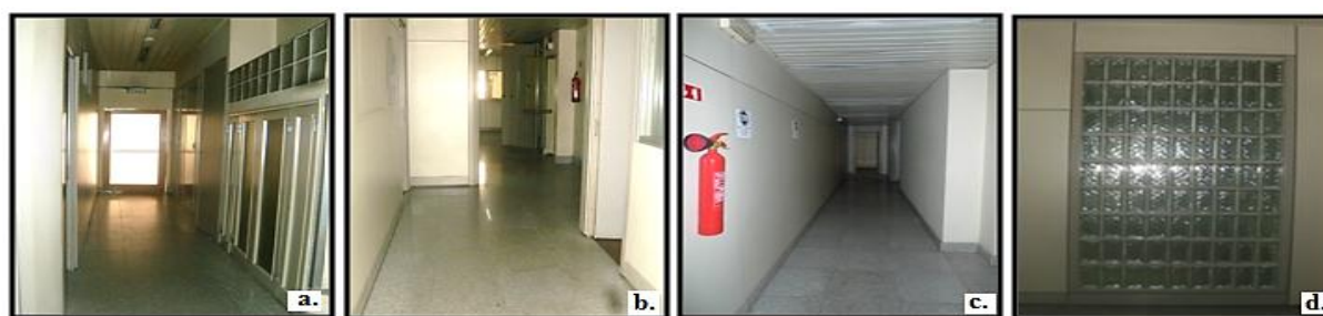
Figura 4.8 - Locais de circulação comum do edifício.
