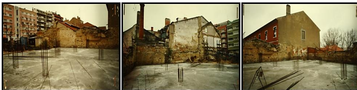
Figura 4.9 - Representação da realização da laje do rés-do-chão do edifício (Arquivo nº 3 do nº de obra: 59 194, CML).
