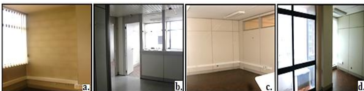
Figura 4.6 - Alguns locais característicos do quinto, sexto e sétimo piso: a. Compartimentação do quarto piso; b. Local de circulação comum no quinto piso; c. Compartimentação do sétimo piso; d. Compartimento do sexto piso.
