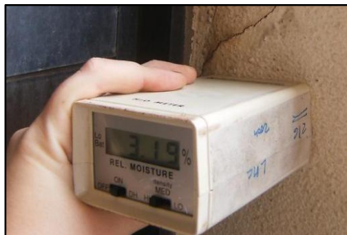
Figura 3.32 - Representação do humídmetro utilizado durante a Inspeção ao edifício em estudo.
