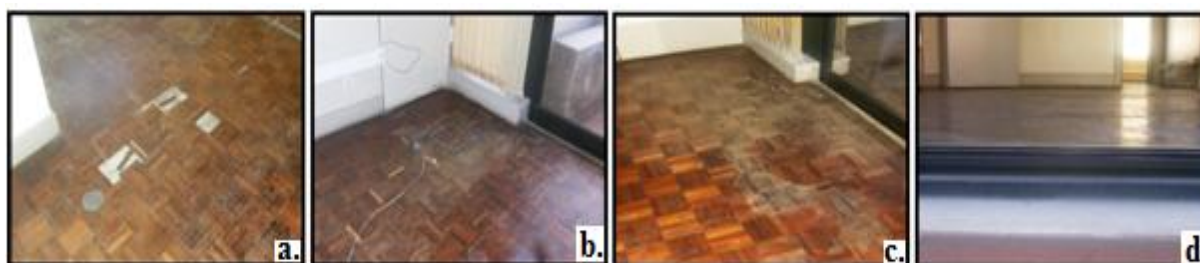
Figura 4.68 – Representação de anomalias do grupo B.: a. Ocorrência da anomalia B.1.(2); b.; c. Ocorrências da anomalia B.5.(2); d. Diferença reduzida de níveis de pavimento interior e exterior.
