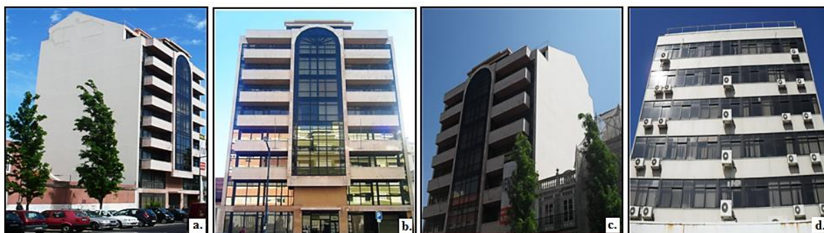
Figura 4.2 - Representação das quatro fachadas principais do edifício: a. Fachada Norte; b. Fachada Frontal (Oeste); c. Fachada Sul; d. Fachada Tardoz (Este).
