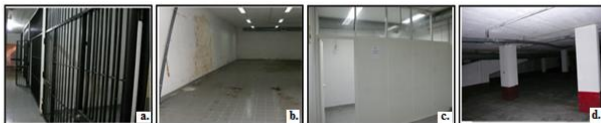
Figura 4.3 - Alguns locais particulares dos pisos inferiores do edifício: a. Local das celas no Piso -1; b. Sala localizada no Piso -2; c. Pormenor de compartimento no Piso -1; d. Local de Estacionamento do Piso -3.
