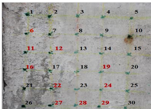
Figura 4.104 - Representação das zonas das medições efetuadas pelo aparelho Esclerómetro Schmidt, no pilarete nº 1, do sétimo piso.
