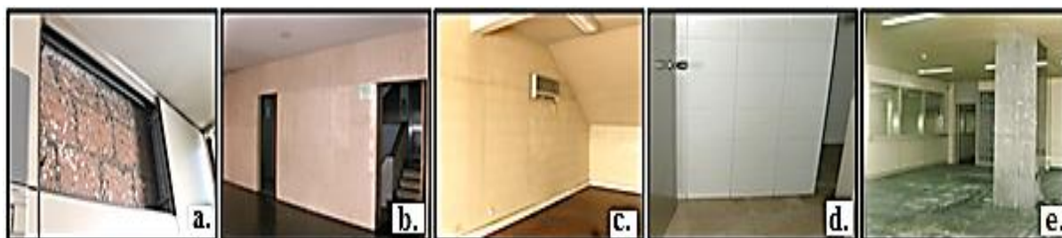
Figura 4.13 - Representação dos diferentes tipos de revestimentos utilizados nas paredes do edifício: a. Colocação de estrutura amovível como revestimento final em parede exterior; b. Revestimento de pedra calcária; c. Parede rebocada e pintada; d. Revestimento cerâmico hidráulico em instalação sanitária; e. Revestimento em pilar de pedra granítica.
