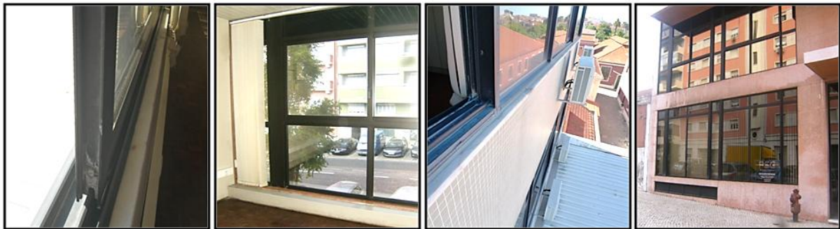
Figura 4.18 - Representação do caixilho de alumínio anodizado em janelas de alguns locais do edifício.
