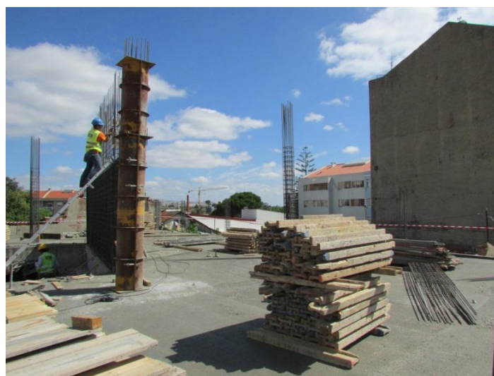
Figura 21 - Execução da laje do teto do piso térreo e continuação dos trabalhos para a laje do teto do Piso 1
