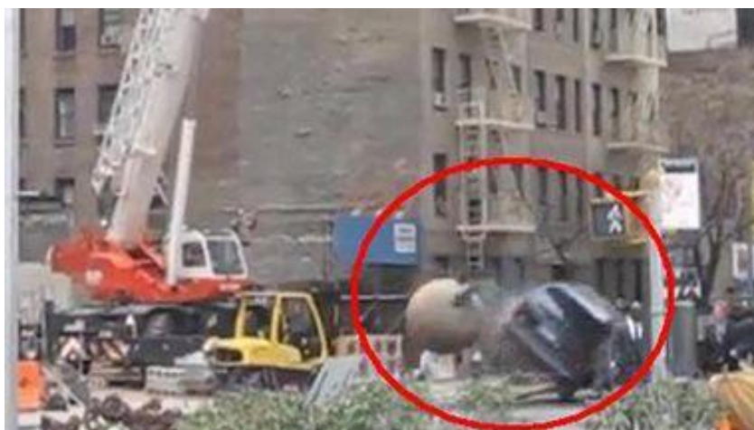
Figura 43 - Demolição com Bola de Grande Massa (Fonte: www.guiadaobra.net)
