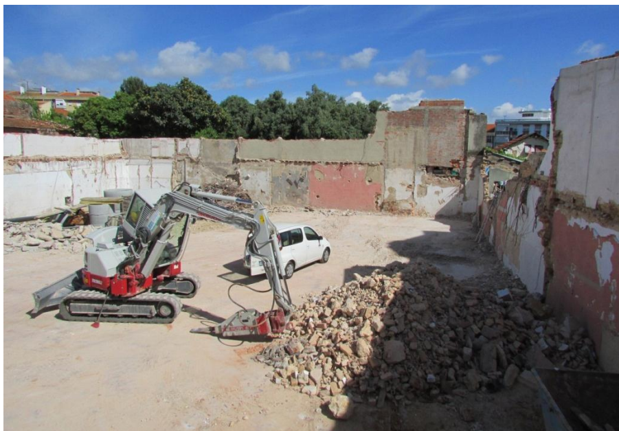
Figura 7 - Lote onde será implantada a Biblioteca Ary dos Santos
