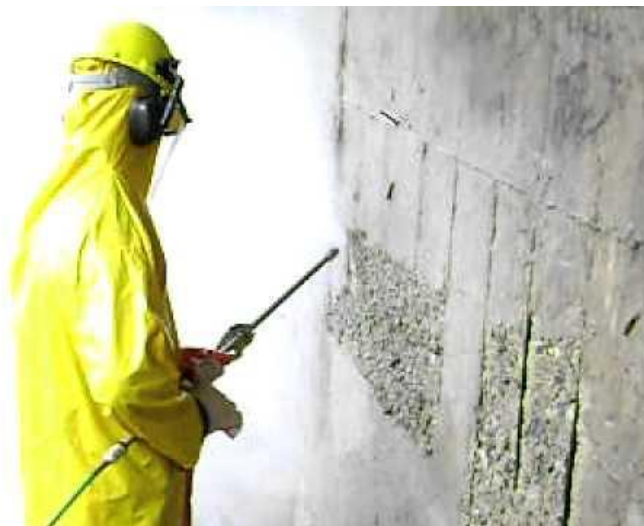
Figura 47 - Hidrodemolição (Fonte: BAL Hidrojato)
