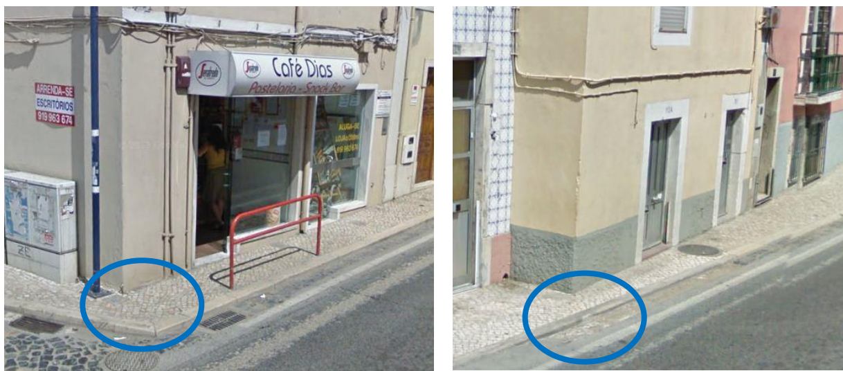
Figura 3 - Exemplo de passeios com largura insuficiente para o trânsito pedestre (Fonte: Google Maps)
