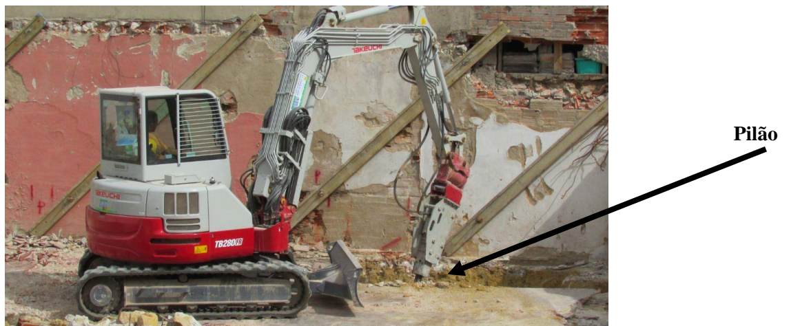
Figura 38 - Furação do Pavimento do Quartel de Bombeiros com recurso à Miniescavadora com Pilão
