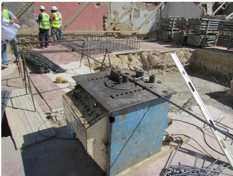
Figura 13 - Máquina de Corte e Dobragem de Aço
