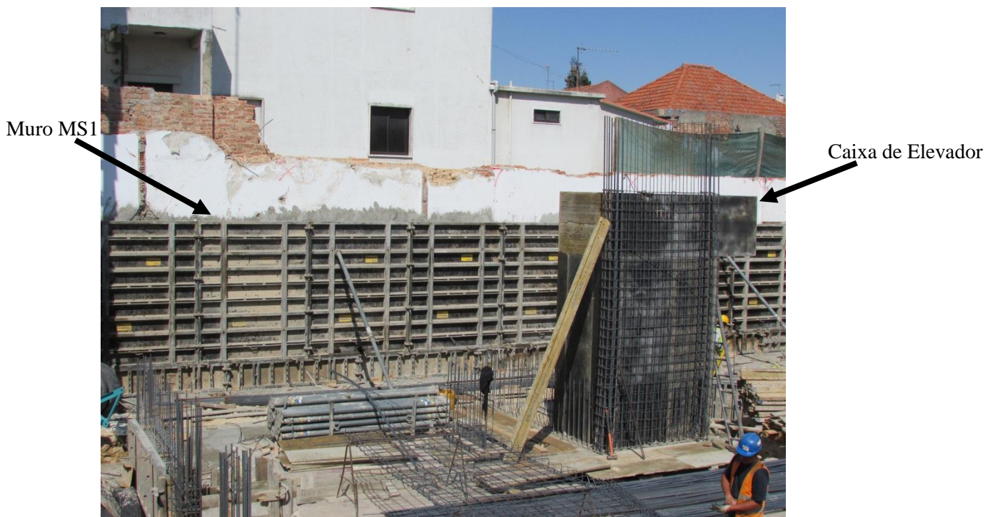
Figura 15 - Continuação das atividades de colocação de armadura e betonagem do Muro MS1
