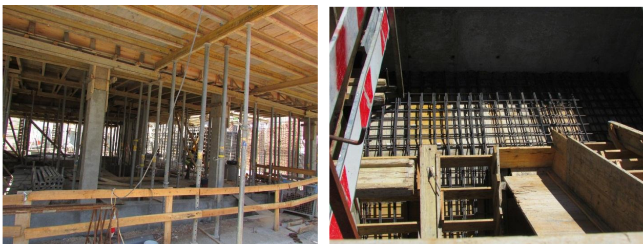
Figura 19 - Escoramento da cofragem da laje do teto do piso térreo e cofragem e armadura da escada
