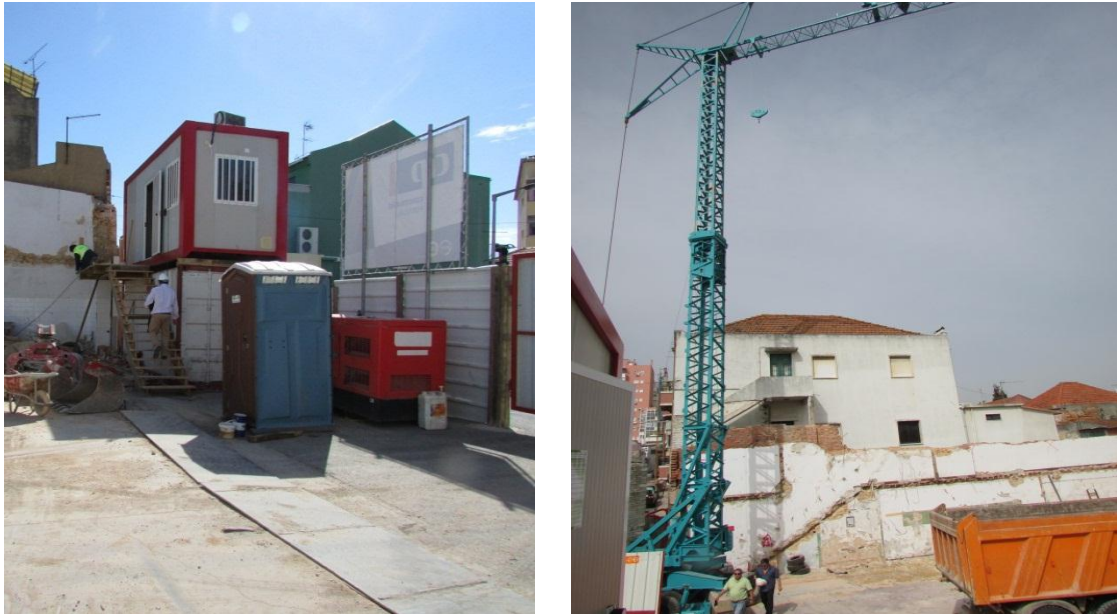
Figura 9 - Instalação do Estaleiro
