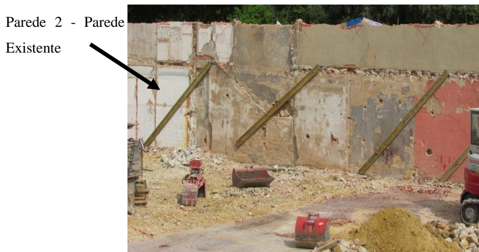
Figura 17 - Parede 2 - Parede Existente
