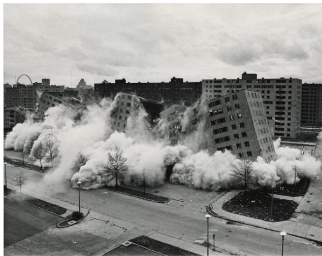
Figura 44 - Demolição com Recursos a Explosivos (Fonte: demolidoraroma.com.br)
