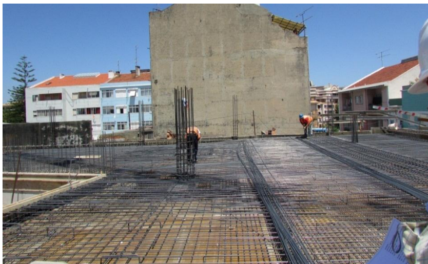
Figura 20 - Armação da laje do teto do piso térreo
