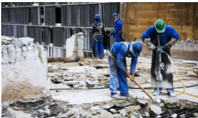
Figura 45 - Top Down - Demolição Manual (Fonte: www.manutencaoesuprimentos.com.br )
