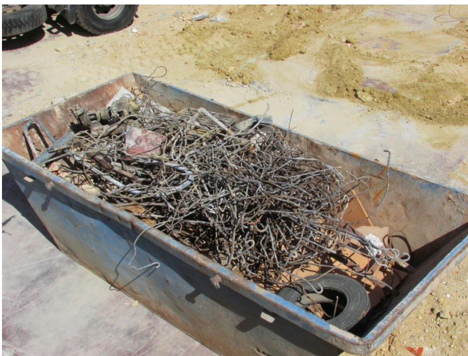
Figura 8 - Recipiente onde se colocaram os RCD de origem metálica
