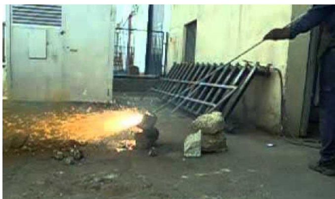
Figura 46 - Utilização da Lança Térmica num bloco de betão (Fonte: PlacidFerrerSL)
