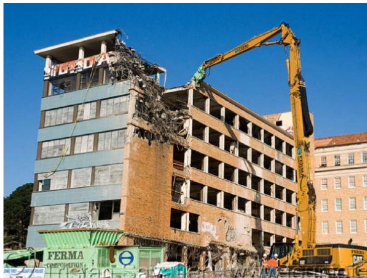
Figura 41 - Demolição com máquina hidráulica de braço longo (Fonte: www.volvoce.com )
