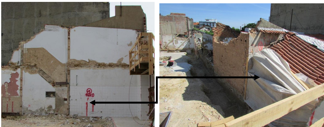
Figura 11 - Parede 3 que funcionava como meã
