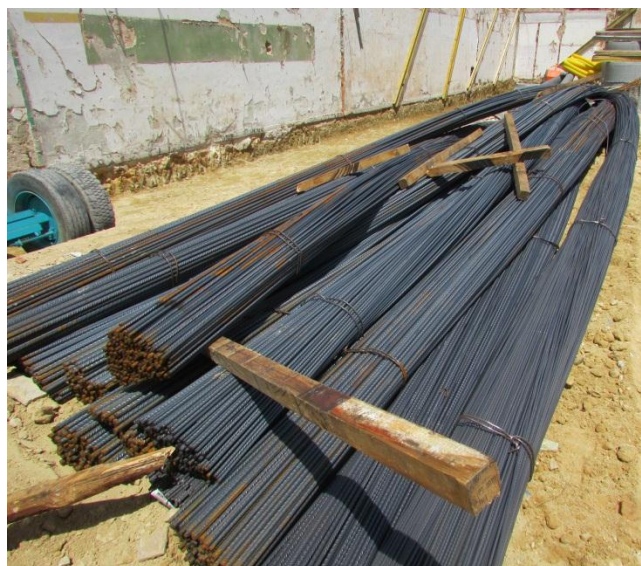
Figura 12 - Chegada e acondicionamento do aço
