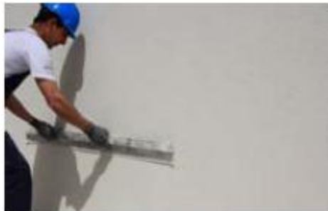
Fig. 5.31 Regularização e aperto da argamassa Isodur [28]
