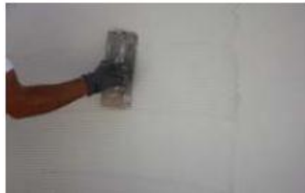
Fig. 5.38 Aplicação do cimento cola ADHERE Multiflex [29]
