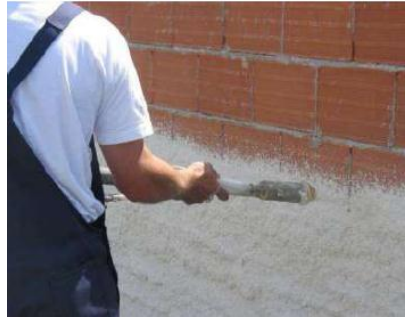
Fig. 5.30 Projeção mecânica do reboco térmico [28]
