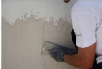
Fig. 5.33 Aplicação da camada de regularização e acabamento Flexdur [24]
