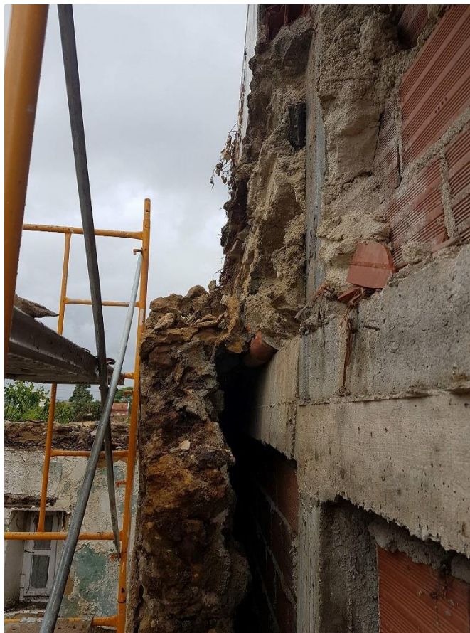
Figura 41 - estrutura de betão armado versus parede meeira
