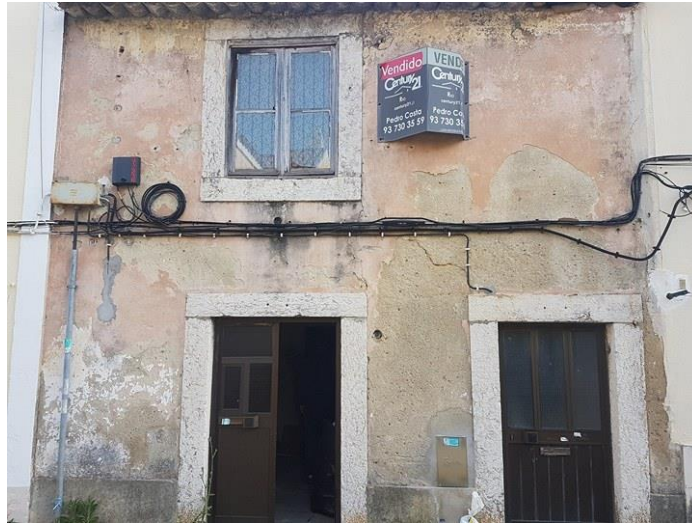
Figura 4 - Fachada existente antes da reabilitação
