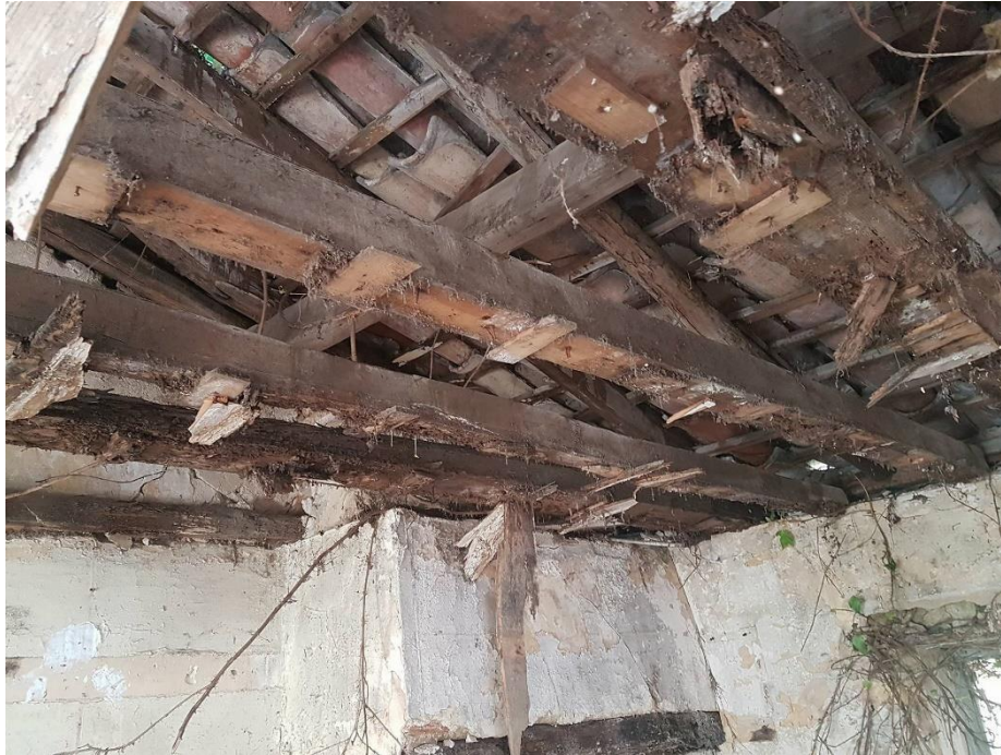
Figura 34 - demolição da laje de esteira
