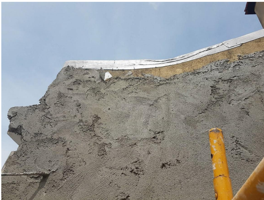
Figura 43 - aspeto final da empena rebocada
