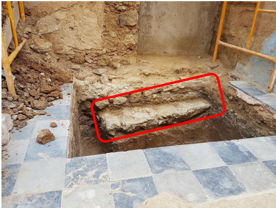
Figura 46 - escavação efetuada no lado esquerdo do edifício
