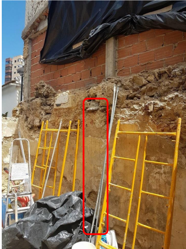
Figura 40 - parede de empena da habitação contígua do lado direito a descoberto
