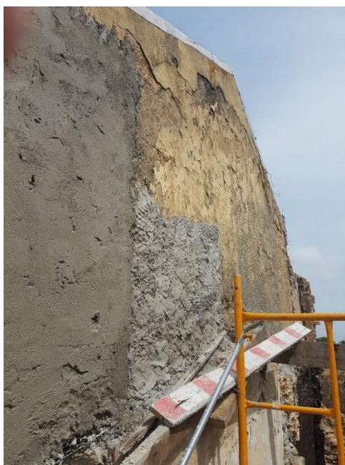
Figura 42 - execução da contenção da empena adjacente com argamassas armadas com rede zincada
