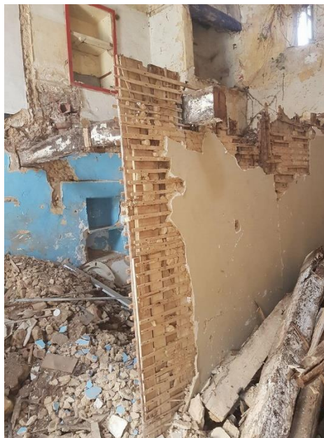
Figura 36 - remoção do revestimento dos tabiques do piso 0
