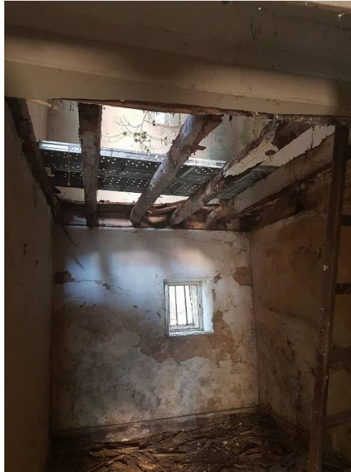
Figura 35 - remoção do teto do piso 0
