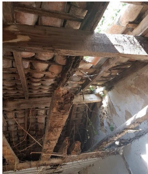
Figura 6 - Estrutura da cobertura e esteira em madeira
