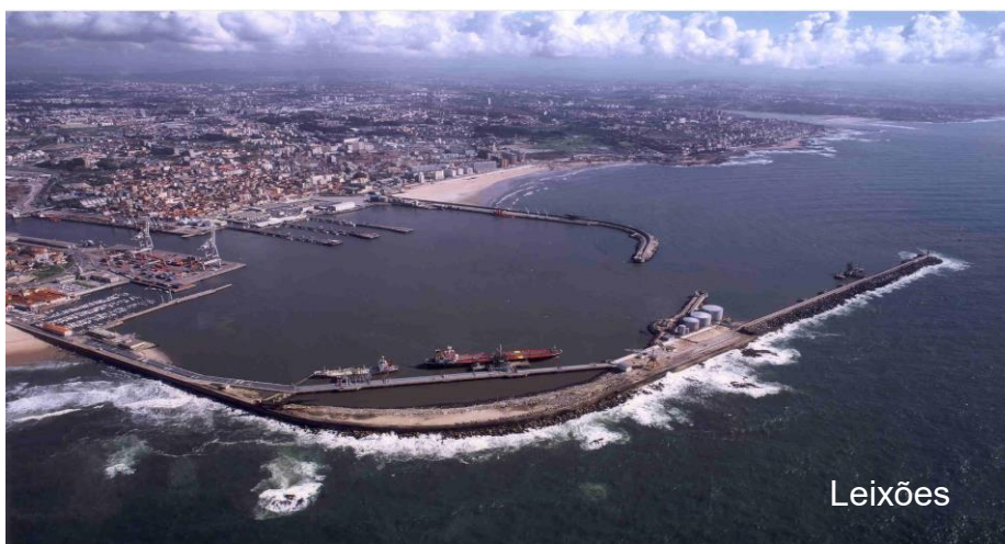
Figura 1.1 – Quebra-mar de Leixões
