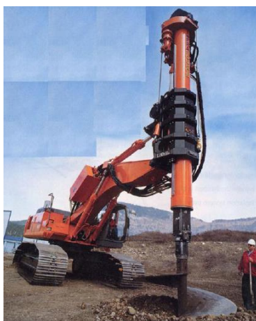
Figura 2 – Abertura de furo (Apolinário, 2016)
