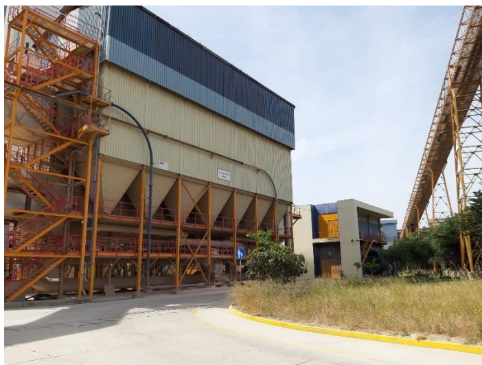
Figura 8 – Filtro de mangas da linha 7
