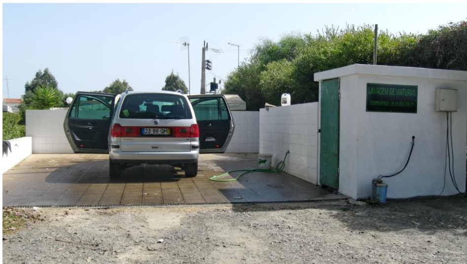
Figura 30 - Zona de lavagem de veículos
