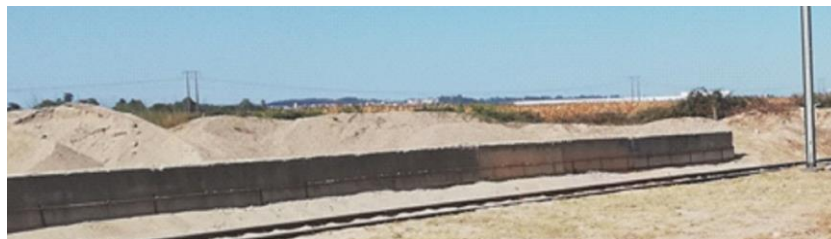
Figura 3-8 – Muro existente a requalificar e ampliar no terminal de areias de Riachos [30]
