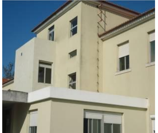
Figura 2.37 - Fachada de tardoz
