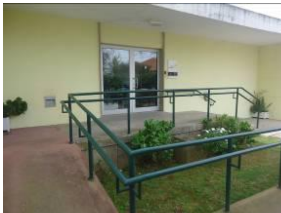
Figura 2.35 - Escadas e rampa de acesso
