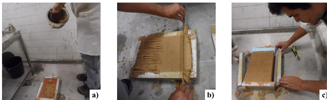
Figura 3.28 – Sequência dos trabalhos de execução das aplicações: a) arremesso da argamassa; b) remoção da argamassa em excesso; c) remoção do molde.
