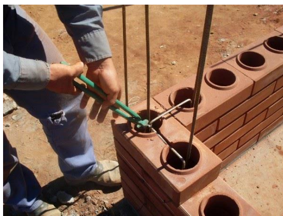
Figura 2.9 – Construção com blocos de terra comprimida (Apuntes de Arquitectura, 2015).
