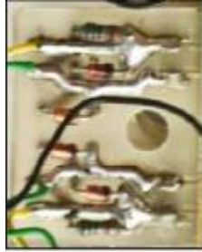
Figura 4. 22 - Placa de proteção dos IGBT's
