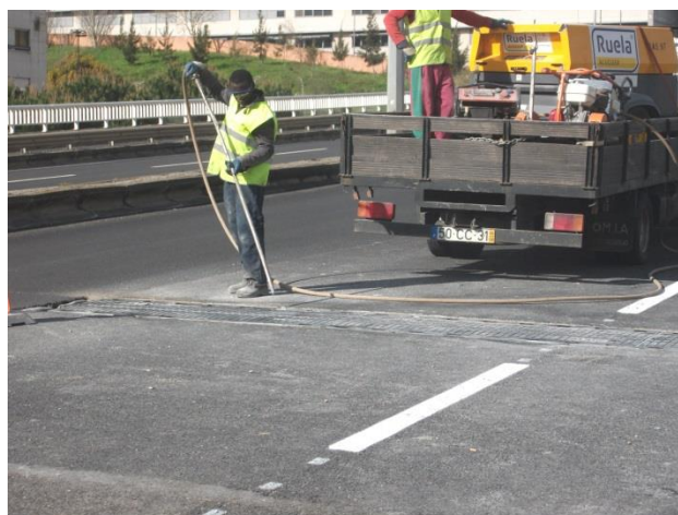
Figura 72 – Limpeza após instalação dos módulos
