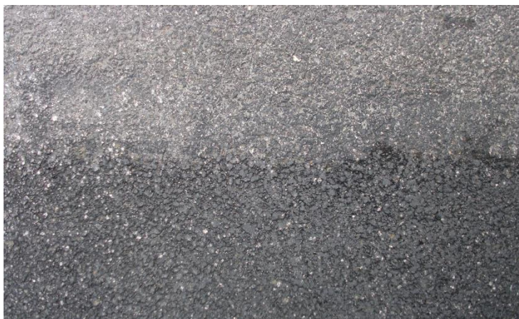
Figura 64 – Transição entre o pavimento antigo e novo
