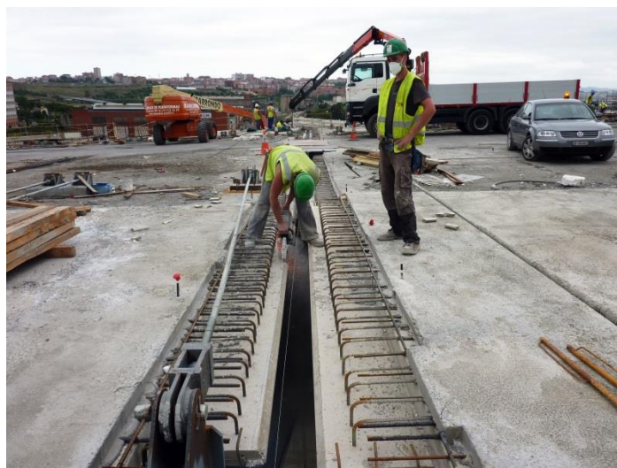
Figura 43 – Preparação para instalação de uma junta de dilatação [ http://mageba.ch ]
