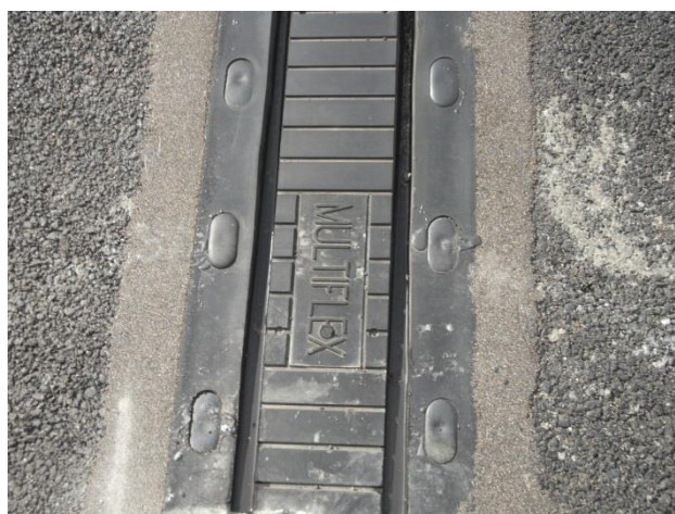
Figura 73 – Junta de dilatação MULTIFLEX concluída
