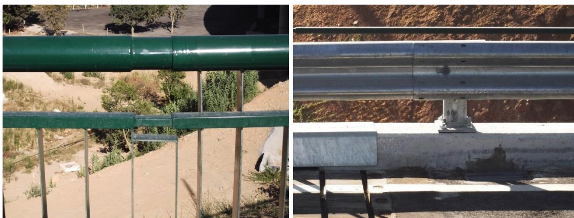
Figura 46 – Guarda corpos (à esquerda) e rail de protecção (à direita)
