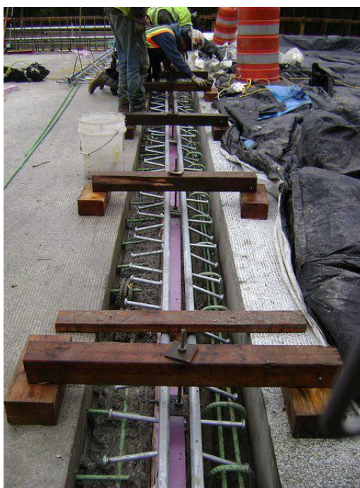
Figura 44 – Colocação da junta de dilatação através de uma construção auxiliar [http://flickr.com]
