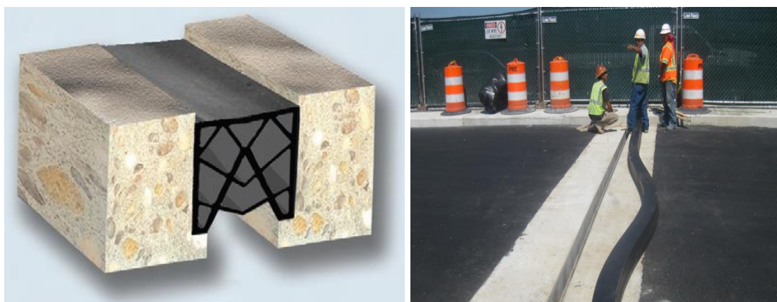
Figura 19 – Junta de compressão em esquema (à esquerda) [21] e aplicação da mesma (à direita) [http://nyavebr.com]
