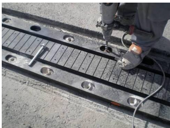
Figura 69 – Perfuração no berço para posterior fixação dos pernos [37]
