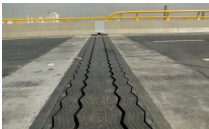
Figura 4 – Junta de dilatação aérea [ http://engenhariae.com.br ]
