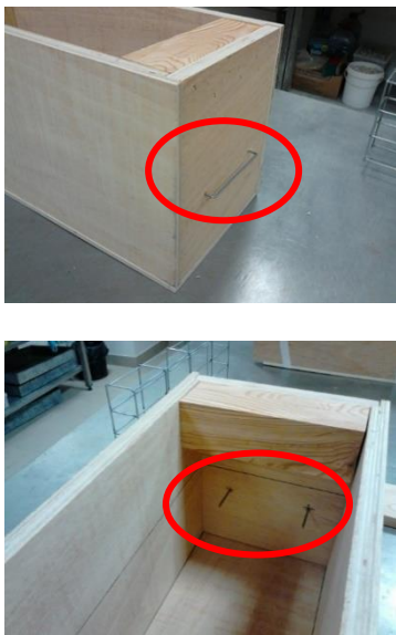
Figura 17 - Suporte para a armadura do bloco (exterior e interior).
