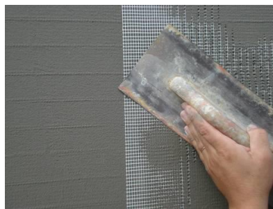
Figura 49 - Barramento delgado armado.
