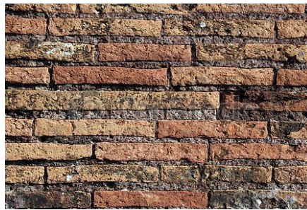
Figura 4 - Parede de tijolo romano
