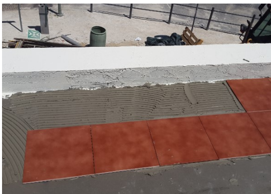
Figura 80 - Aplicação do ladrilho cerâmico
