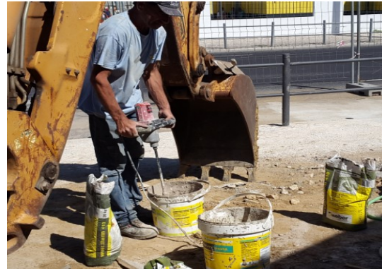
Figura 61 - Mistura da argamassa de colagem
