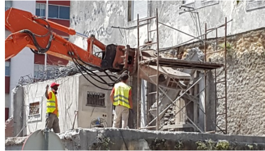
Figura 37 - Lança da escavadora
