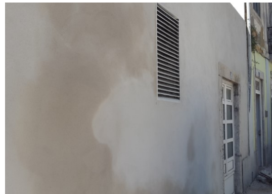
Figura 59 - Aspecto depois do reboco aplicado
