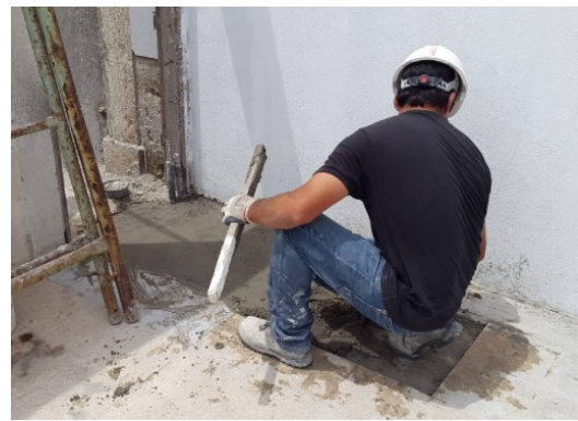
Figura 73 - Aplicação de argamassa
