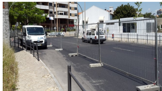
Figura 5 - Montagem rede bekaert
