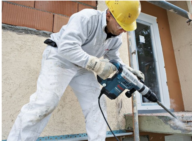
Figura 13 - Demolição Tradicional (Fonte: Bosch)
