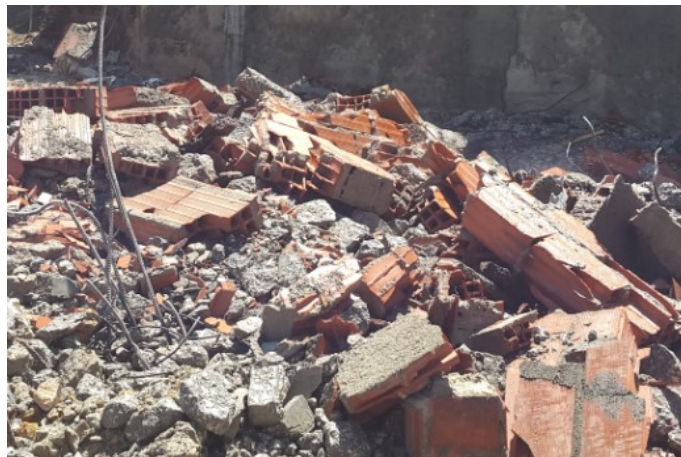
Figura 38 - Resíduos da demolição
