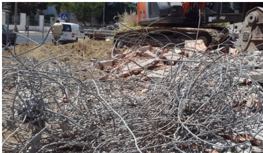
Figura 40 - Varões resultantes da demolição
