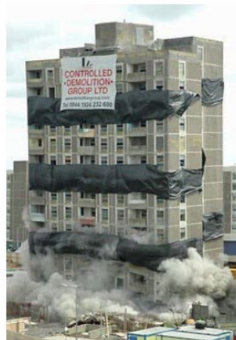
Figura 24 - Demolição com recurso a cargas explosivas (Fonte: Verlag Dashofer)
