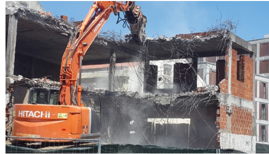
Figura 29 - Desmonte da Cobertura
