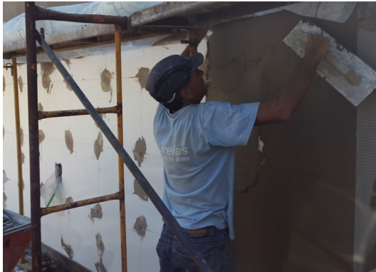
Figura 68 - Revestimento do EPS
