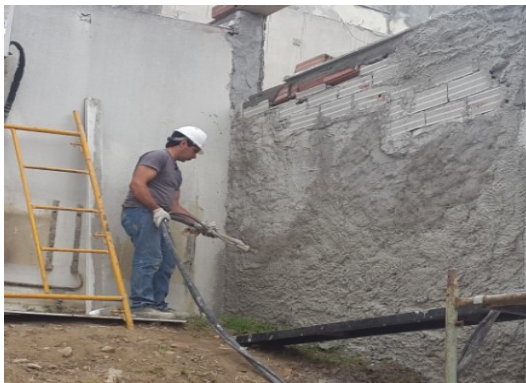
Figura 56 - Aplicação de reboco projectado
