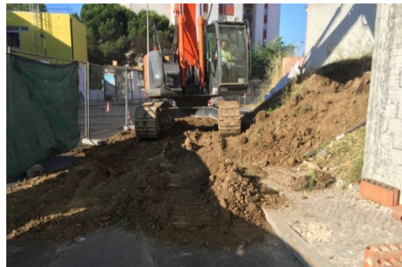
Figura 27 - Preparação da base de trabalho
