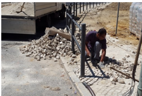
Figura 46 - Colocação de calçada
