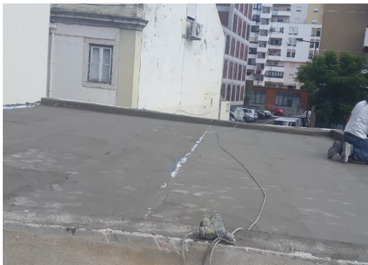
Figura 78 - Cobertura com a membrana elástica
