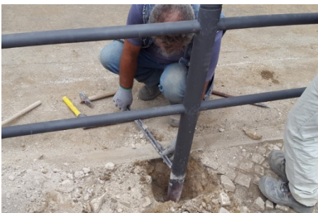
Figura 49 - Montagem dos pilaretes
