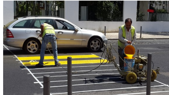
Figura 7 - Pintura provisória da passadeira
