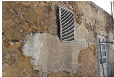
Figura 52 - Parede de alvenaria de pedra
