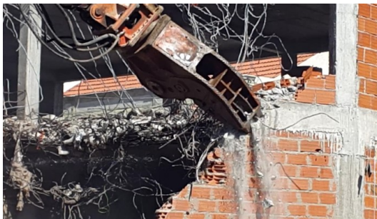
Figura 30 - Esmagamento do betão
