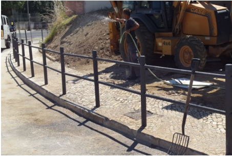
Figura 47 - Molhagem da calçada
