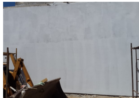
Figura 71 - Aplicação de primário
