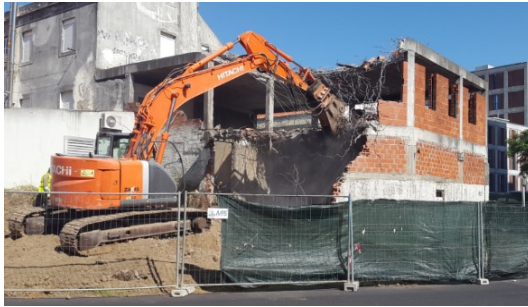
Figura 28 - Início dos trabalhos de desmonte
