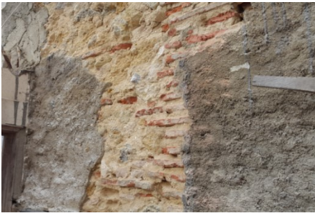
Figura 51 - Parede com tijolo cerâmico
