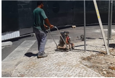
Figura 48 - Compactação com placa vibratória
