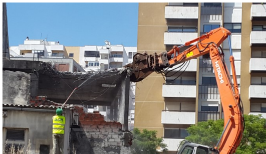
Figura 34 - Continuação dos trabalhos de desmonte
