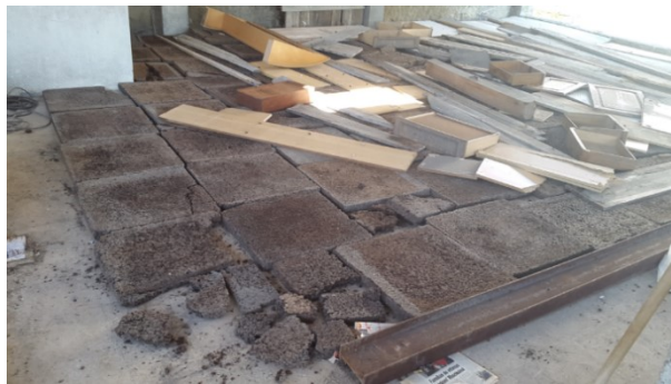
Figura 12 - Protecção de ladrilhos
