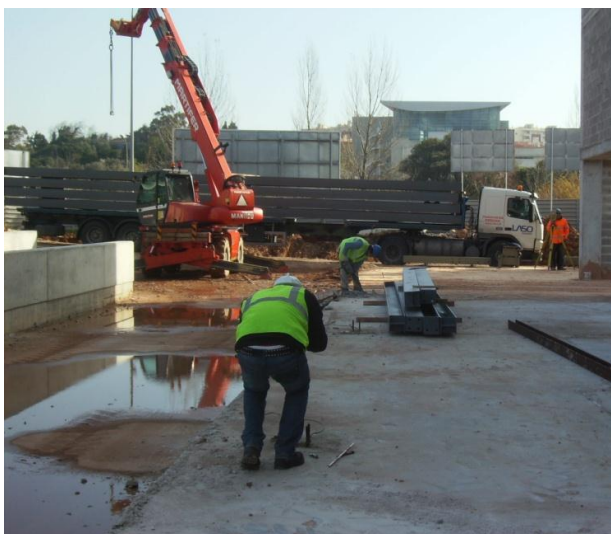
Figura 34 – Verificação topográfica do posicionamento dos chumbadouros
