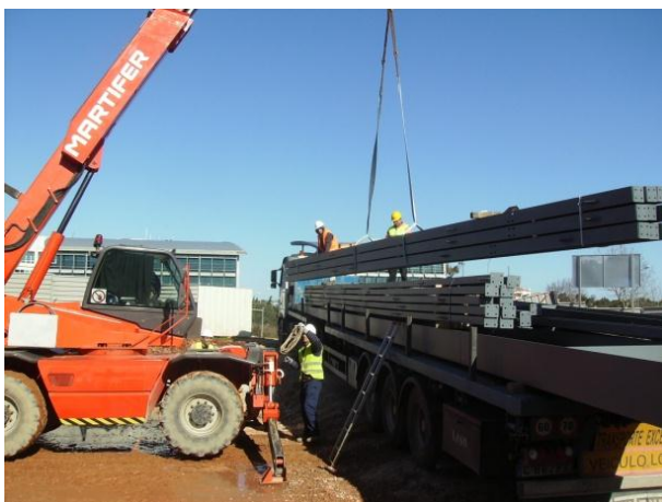
Figura 41 – Descarga das peças da estrutura metálica
