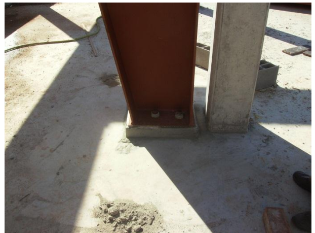
Figura 93 – Selagem do chumbadouro
