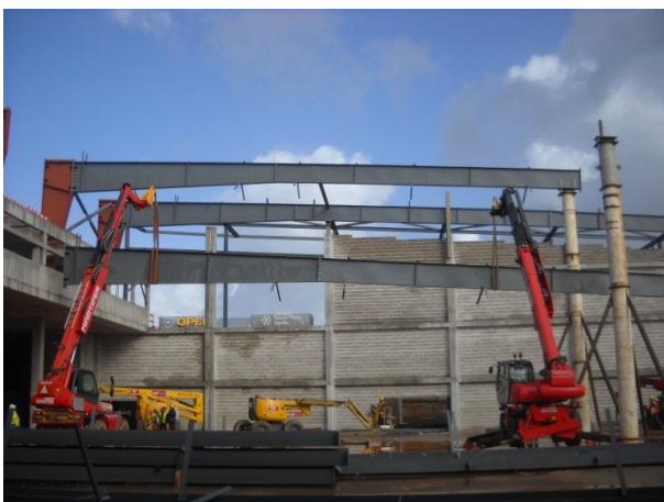
Figura 75 – Elevação da asna da primeira fase com duas empilhadoras em paralelo
