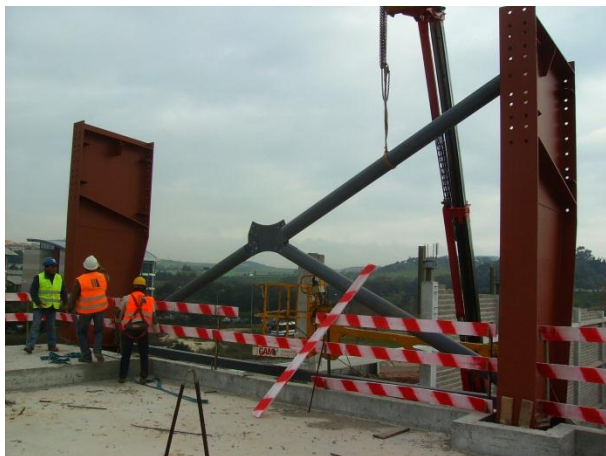
Figura 70 – Montagem dos contraventamentos de pilares
