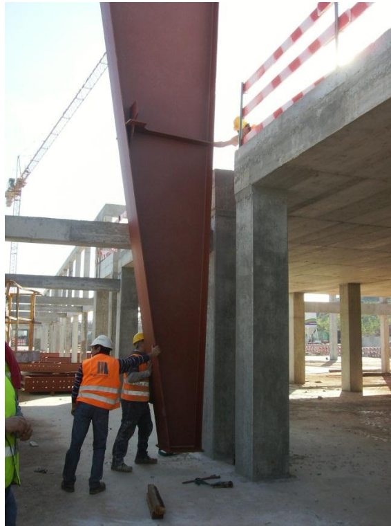
Figura 66 – Colocação do pilar no chumbadouro
