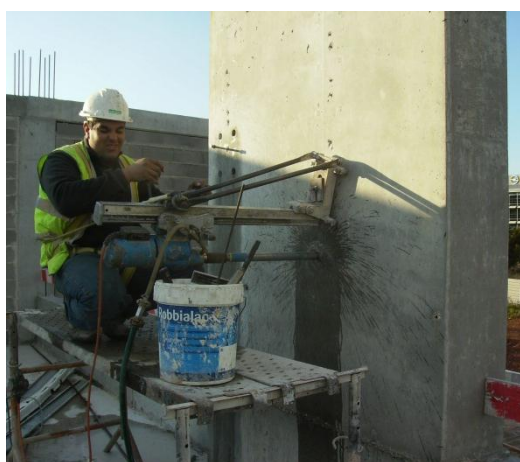
Figura 77 – Furação de pilar de betão armado para ligações asna-pilar
