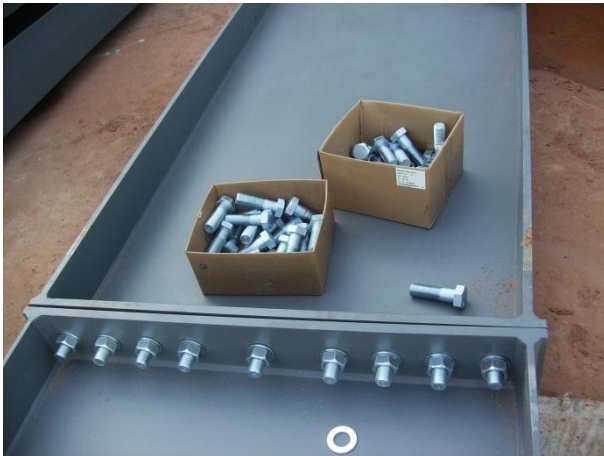
Figura 72 – Ligações aparafusadas executadas no solo
