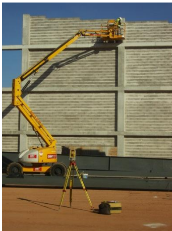
Figura 60 – Trabalhos topográficos para a localização da furação dos pilares
