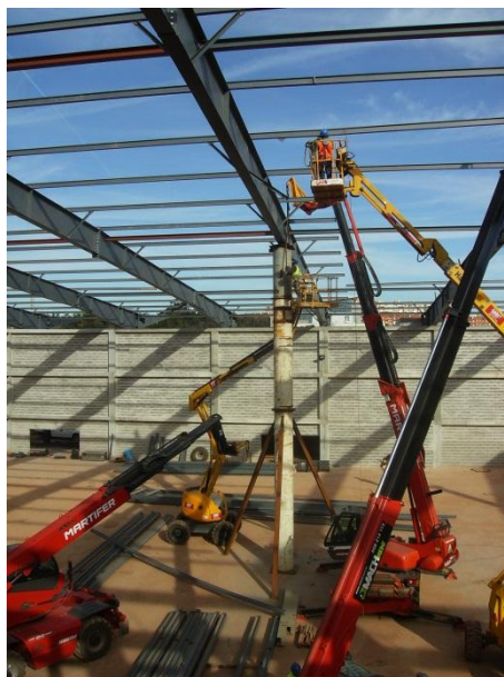
Figura 87 – Montagem de madre e desmontagem de torre de escoramento
