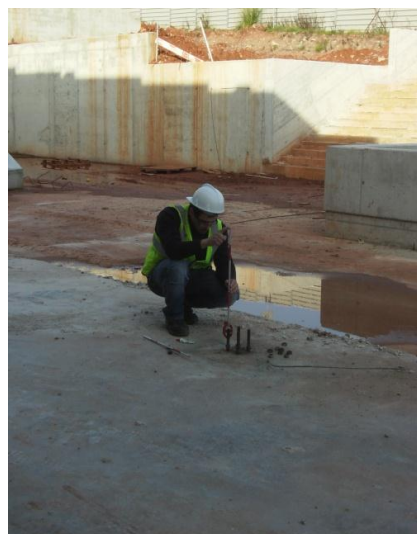
Figura 35 - Verificação topográfica do posicionamento dos chumbadouros
