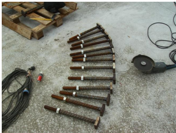
Figura 33 – Pernos dos chumbadouros
