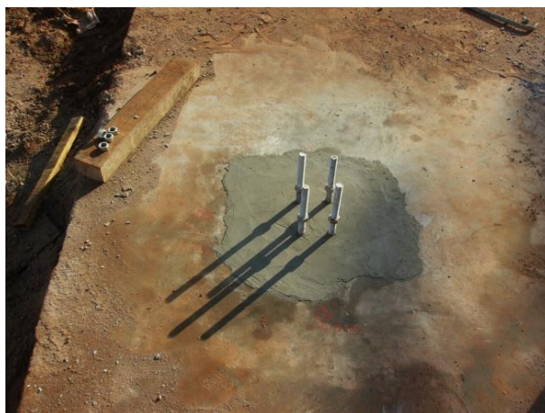
Figura 39 – Vista após colocação do “grout”
