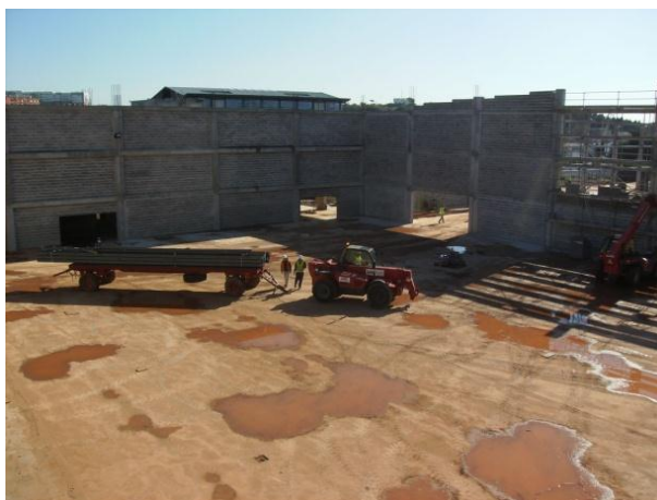
Figura 42 – Transporte das peças para o estaleiro
