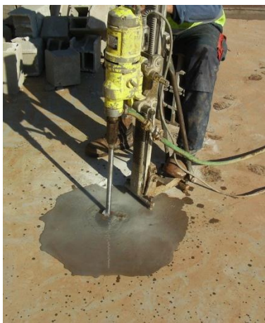
Figura 56 – Furação da laje para fixação das torres de escoramento
