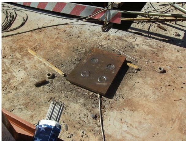
Figura 90 – Chapa soldada aos pernos do chumbadouro
