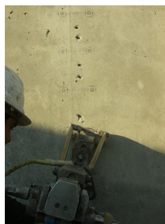
Figura 78 – Pormenor da furação de pilar de betão armado nas marcações topográficas
