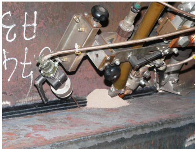
Figura 26 – Execução de soldadura com arco submerso [6]
