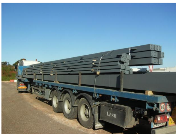
Figura 40 – Camião de transporte das peças da estrutura metálica
