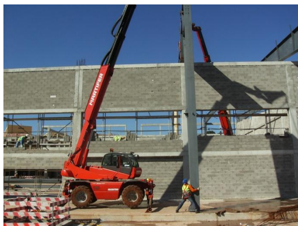
Figura 49 – Colocação e elevação de um pilar
