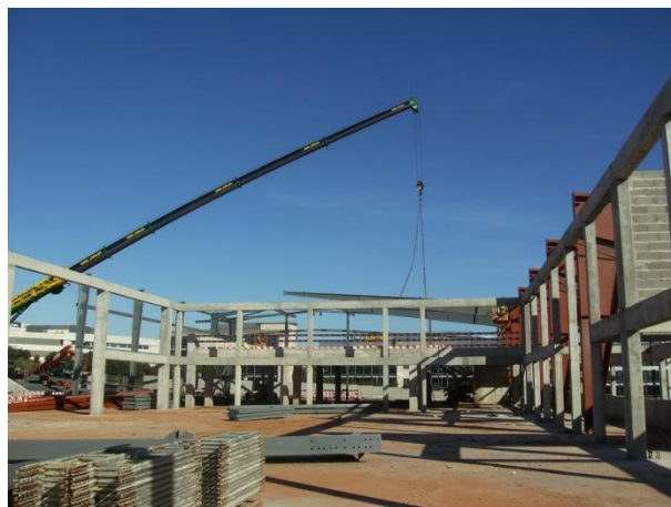
Figura 47 – Colocação de asna por uma grua móvel
