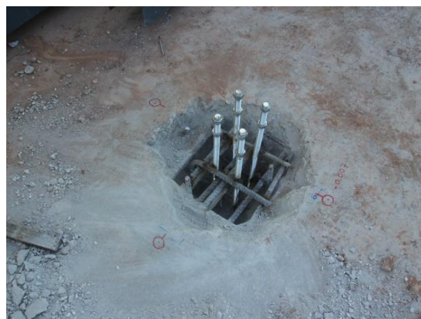
Figura 38 – Colocação dos pernos do chumbadouro
