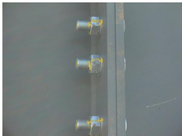
Figura 89 – Marcação das ligações inspeccionadas
