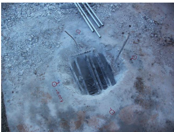
Figura 37 – Abertura de roço
