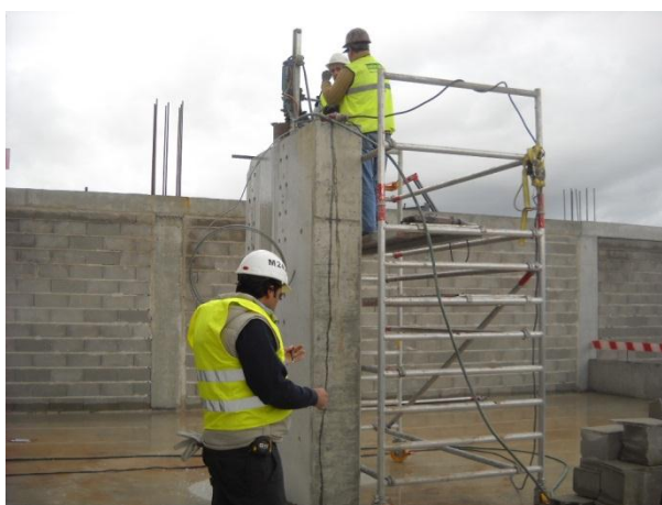
Figura 79 – Furação do topo do pilar de betão armado para encastramento da asna
