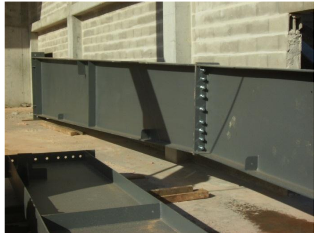
Figura 73 – Vista da asna pronta a colocar
