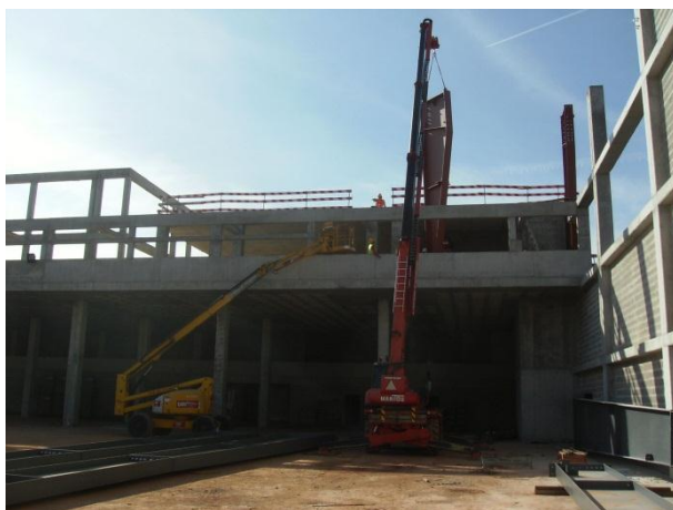
Figura 64 – Elevação de pilar a cotas diferentes
