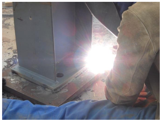
Figura 91 – Soldadura com eléctrodos revestidos da base do pilar à chapa
