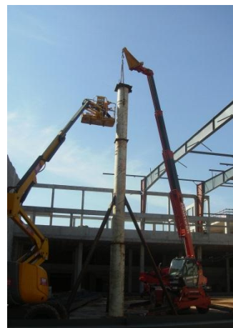
Figura 57 – Colocação de torre de escoramento
