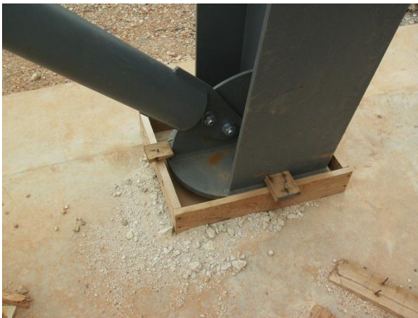
Figura 92 – Cofragem da zona a encher com “grout”
