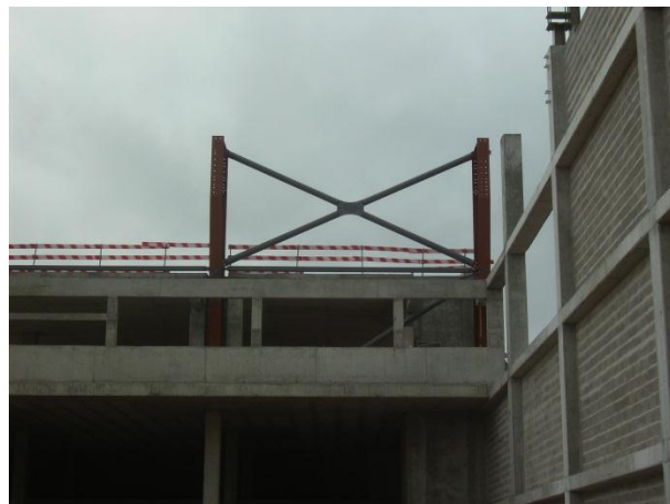
Figura 71 – Contaventamento de pilares
