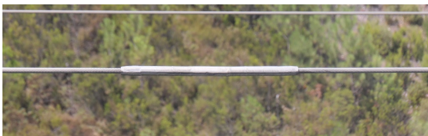
Figura 2.29 - União instalada num cabo
