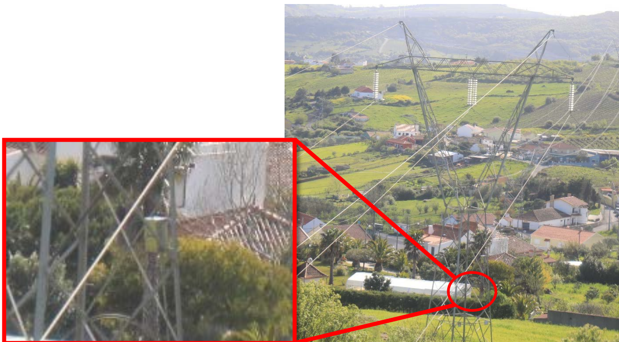
Figura 2.30 - Instalação de caixa OPGW
