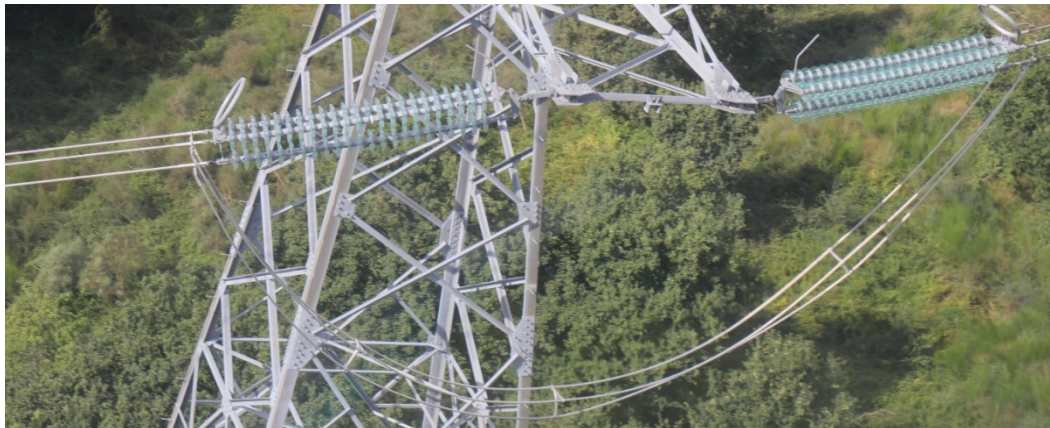
Figura 2.13 - Cabo condutor em feixe triplo
