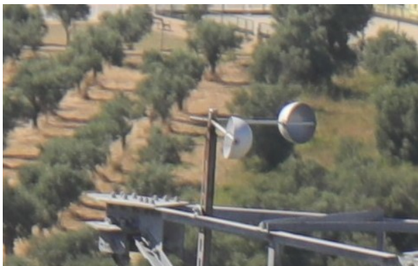
Figura 3.5 - Inibidor de poiso partido
