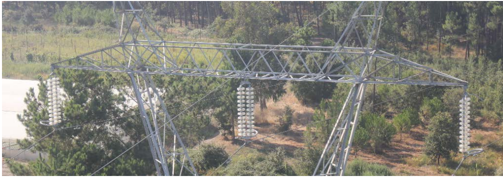
Figura 2.23 – Cadeia de suspensão
