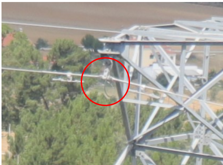
Figura 2.28 - Fixação de cabo OPGW a um apoio
