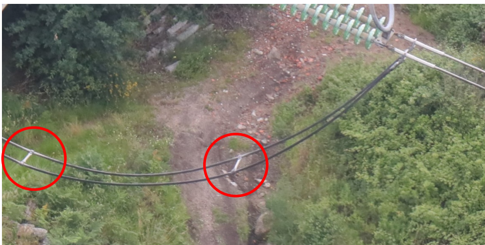
Figura 2.36 - Separador duplo instalado em fiador em amarração
