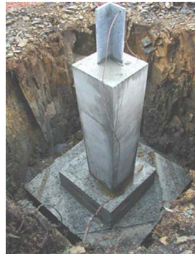
Figura 2.20 - Fundação de apoio reticulado (Moreira, 2005)
