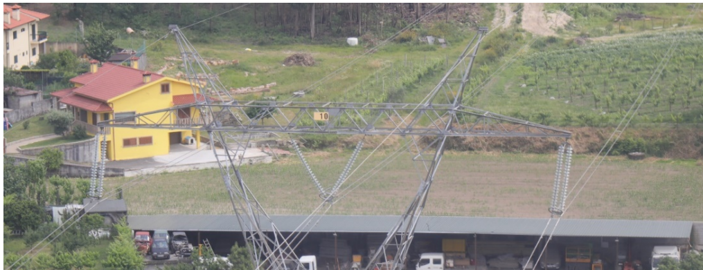
Figura 2.24 - Apoio em suspensão com ligeira mudança de direção
