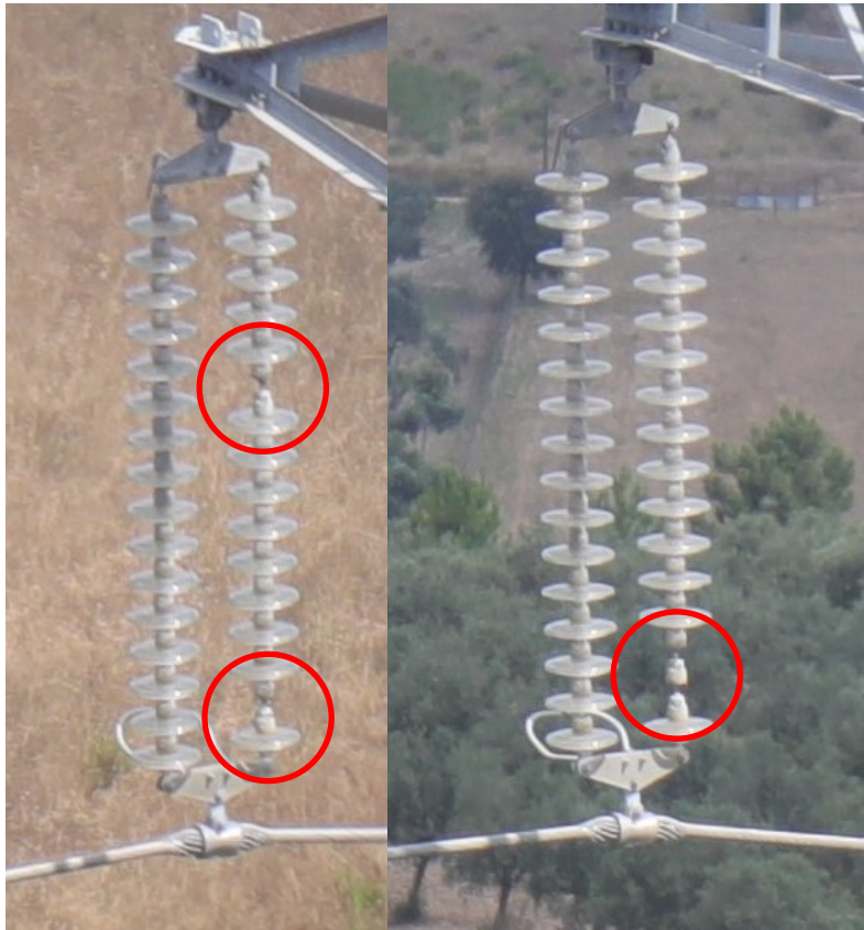
Figura 3.14 - Dois isoladores partidos na mesma cadeia em linha de 220kV - Alternados (Esq º ) e Consecutivos (Dt º )
