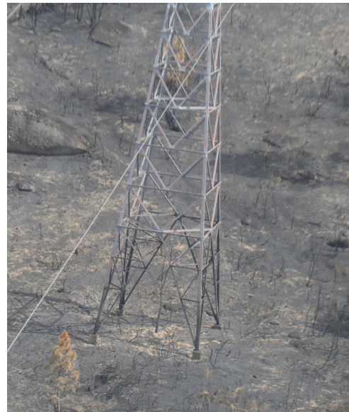
Figura 3.4 - Base de apoio queimada
