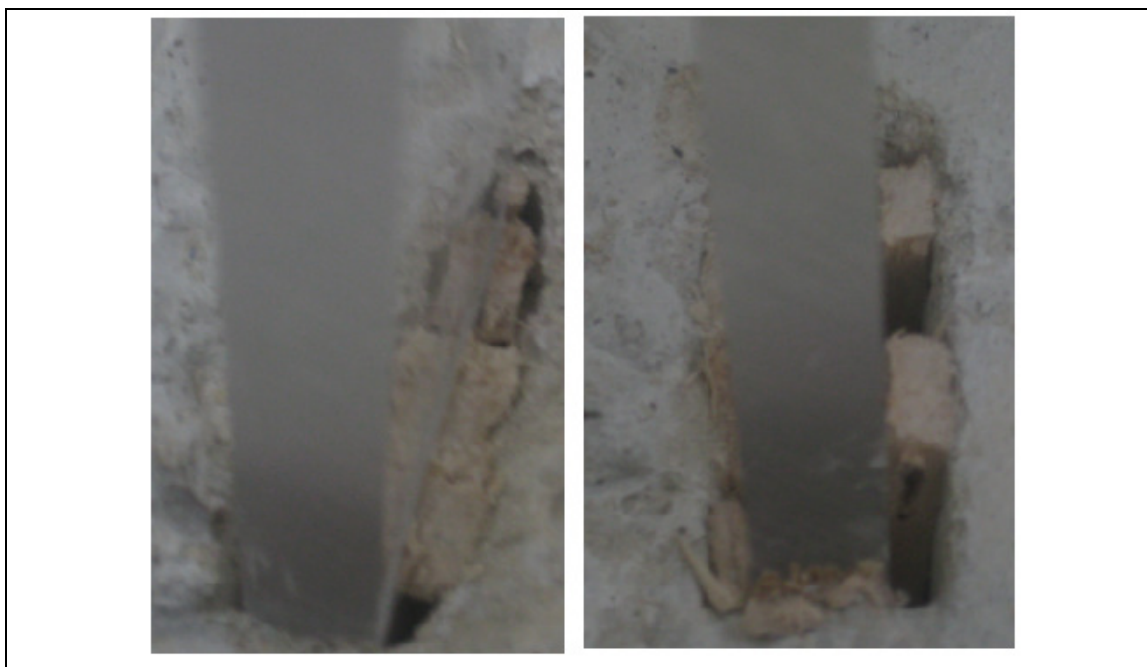
Figura 4.6 Pormenor dos encastramentos dos pilares.
