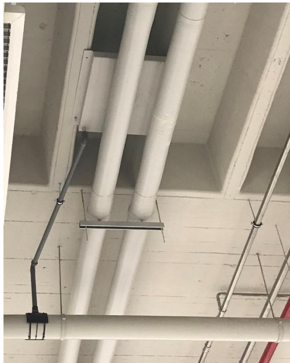
Figura 38. Tabuleiro no teto do edifício C (Imagem do autor)
