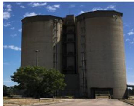
(b) Silos de armazenagem
