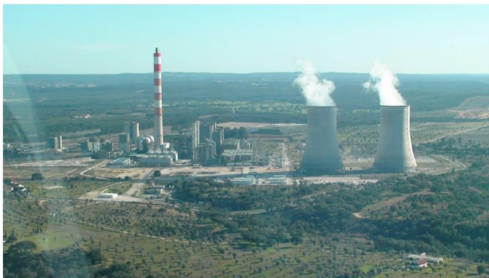
Figura 4 - Vista geral da Central Termoelétrica do Pego.
