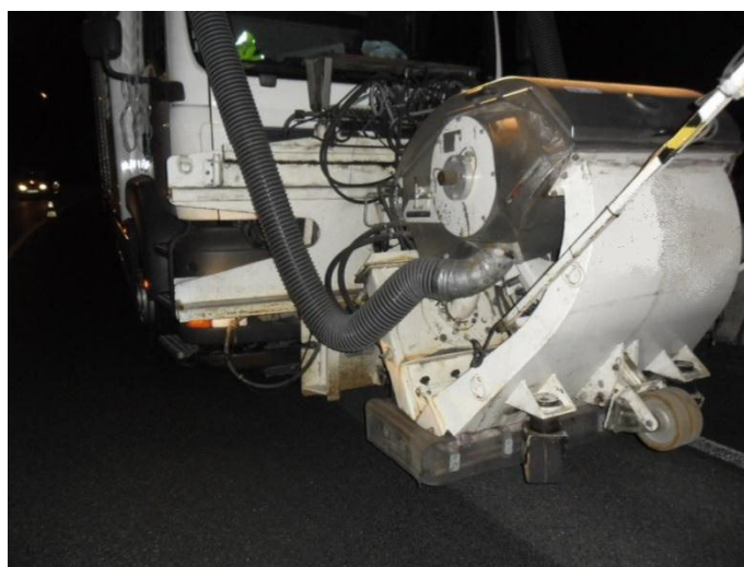
Figura 4.12 – camião com o equipamento de granalhagem
