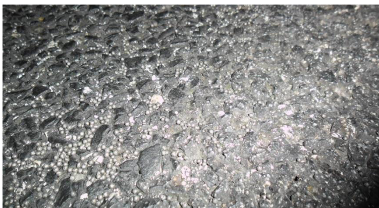
Figura 4.11 – Pavimento após ação de granalhagem
