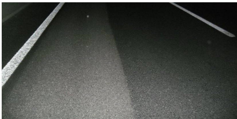
Figura 4.15 – Primeira passagem do equipamento de granalhagem
