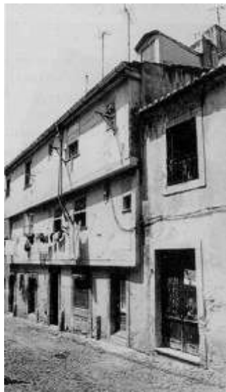
Figura 25 - Edifício com andar de ressalto
