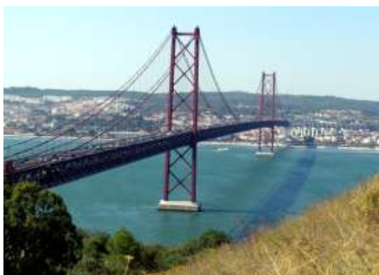
Figura 37 - Ponte 25 de Abril, Lisboa - Aplicação do Aço
