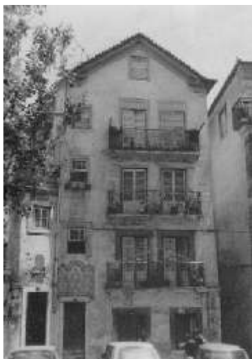
Figura 26 - Edifício de fachada de bico
