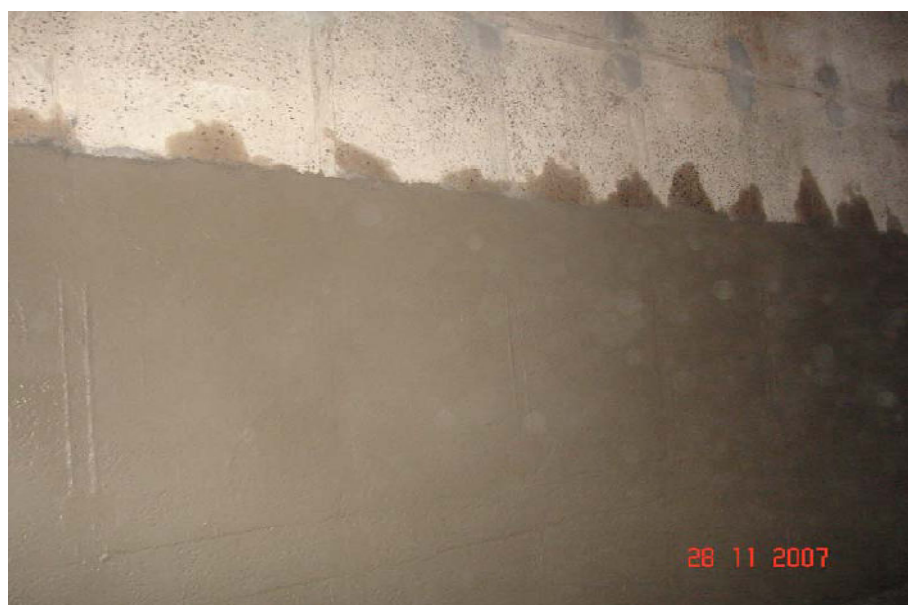
Figura 4 - Exemplo de aplicação do sistema de cimentos poliméricos numa parede
