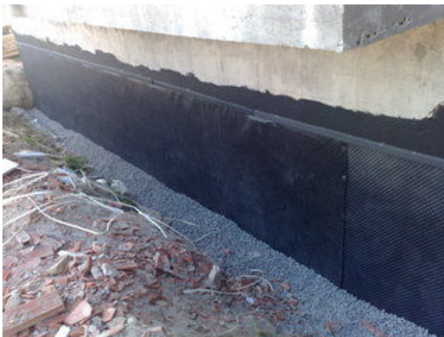
Figura 5 - Exemplo de aplicação do sistema de emulsão betuminosa
