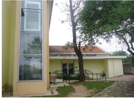
Figura 2.9 - Fachada a Este (Entrada para a UCC Girassol). (arquivo de SF)
