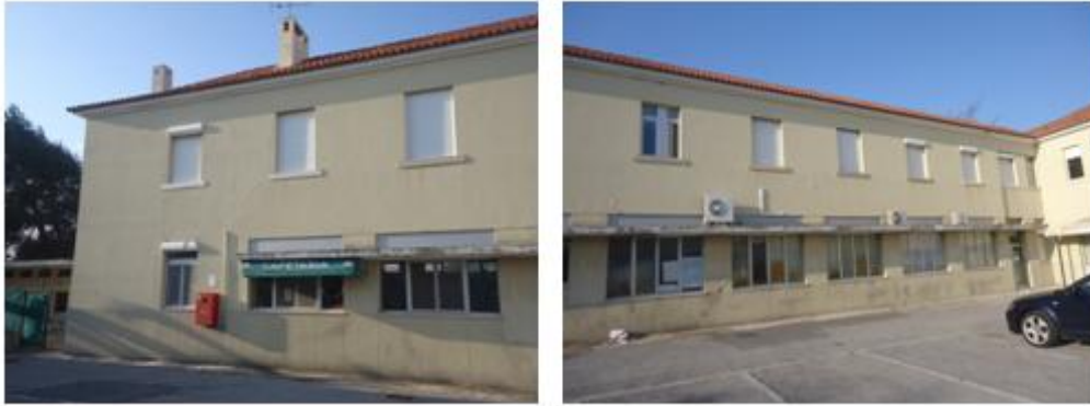
Figura 3.26 - Fachadas a Sul. (arquivo de SF)
