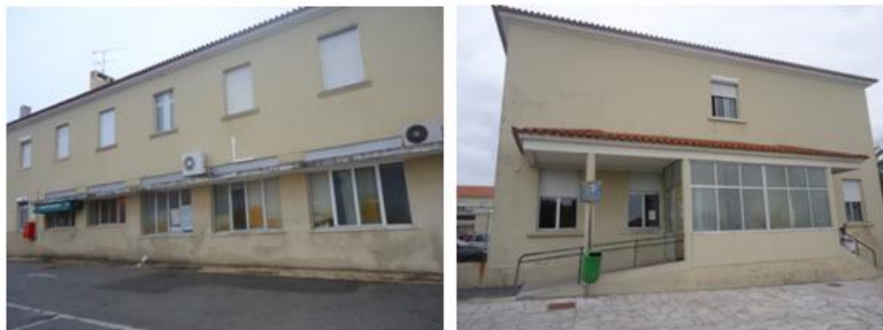
Figura 2.7 - Fachadas a Sul (à esquerda: Piso 0 - Zona de esterilização e Piso 1 - USF Kosmus; à direita: entrada para o Atendimento Complementar). (arquivo de SF)
