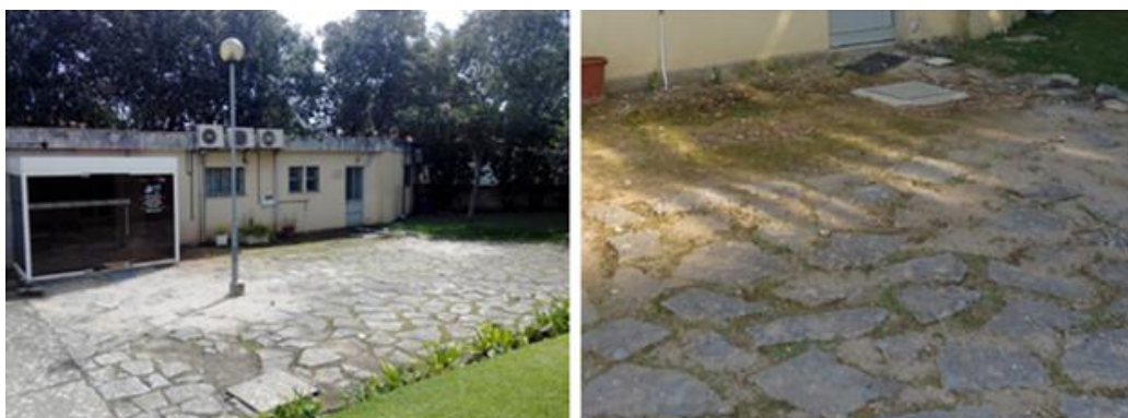
Figura 3.48 - Pavimento no pátio da URAP. (arquivo de SF)
