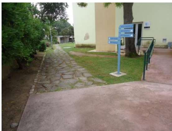
Figura 4.39 - Pavimento a substituir. (arquivo de SF)
