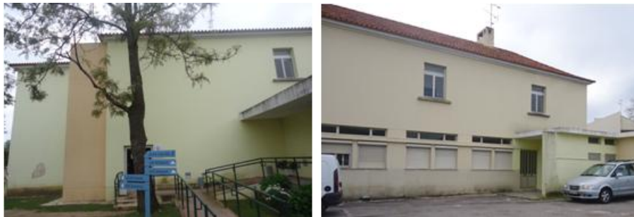
Figura 2.6 - Fachadas a Norte (à esquerda: entrada da USF Kosmus; à direita: Piso 0 - Zona de esterilização e Piso 1 - USF Kosmus. (arquivo de SF)
