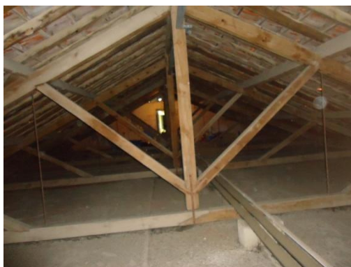
Figura 3.34 - Estrutura de madeira. (arquivo de SF)
