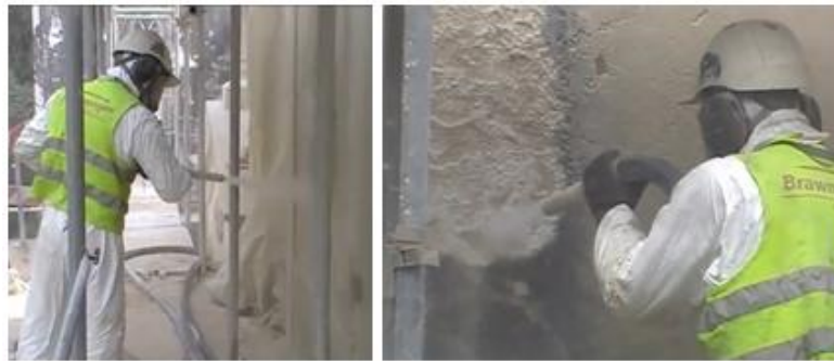
Figura 4.1 - Aplicação de jato de areia. (17)
