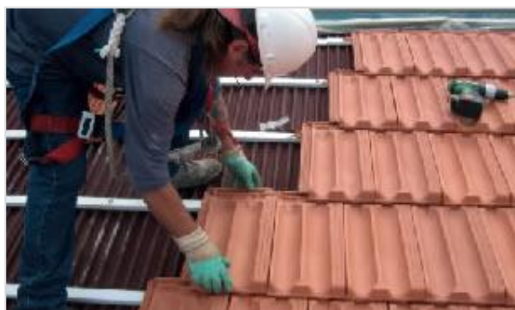
Figura 4.22 - Aplicação de telha Marselha sobre subtelha. (I19)
