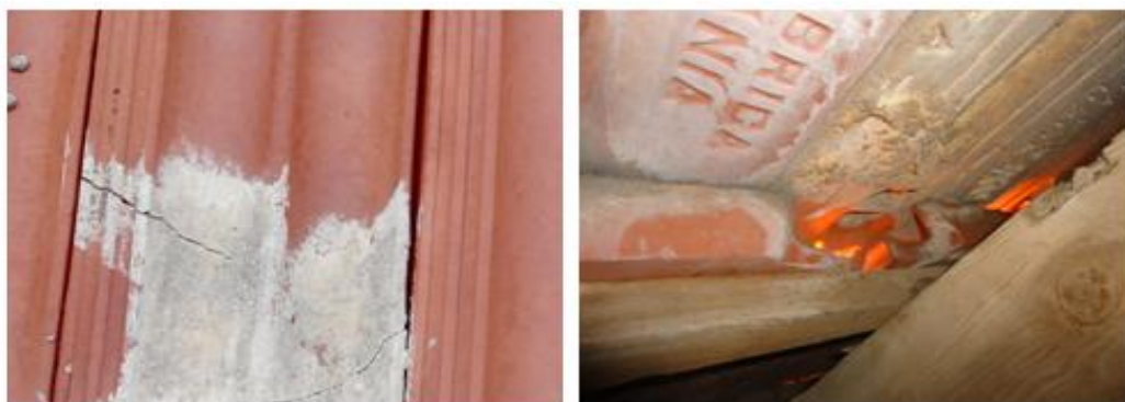
Figura 3.28 - Pormenor das telhas. (arquivo de SF)
