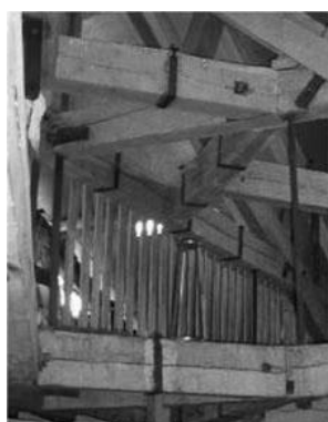
Figura 4.24 - Reparação de fendas por cintagem. (I6)
