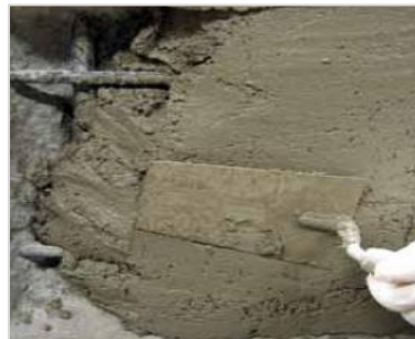
Figura 4.11 - Restituição da forma original do betão. (I14)
