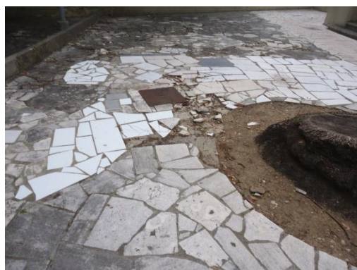
Figura 3.51 - Pormenor do pavimento junto ao cepo. (arquivo de SF)
