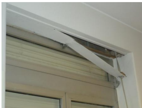
Figura 3.24 - Caixa de estore aberta numa das salas. (arquivo de SF)
