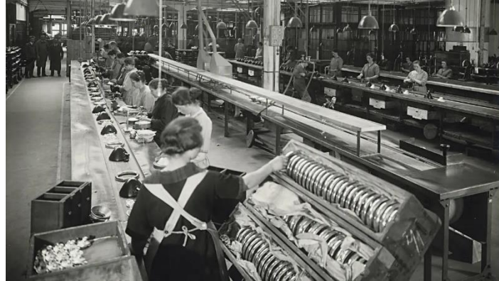
Figura 1 - Produção através de linha de montagem na Bosch.
