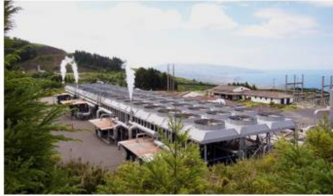
Figura 3.3 - Central Geotérmica da Ribeira Grande na Ilha de São Miguel [67]
