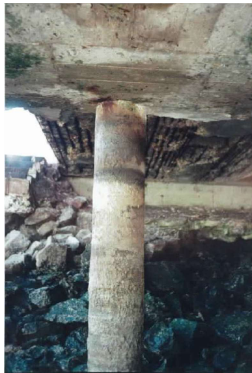
foto 8 – Pormenor de laje a demolir e a reconstruir
