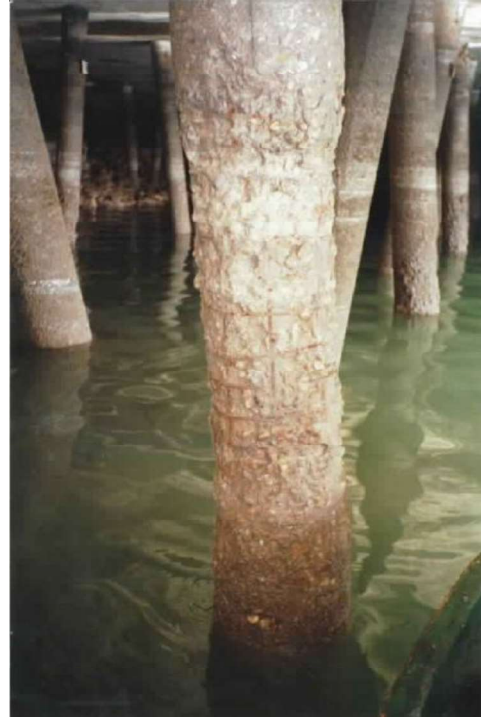
foto 4 – Estacas deterioradas
