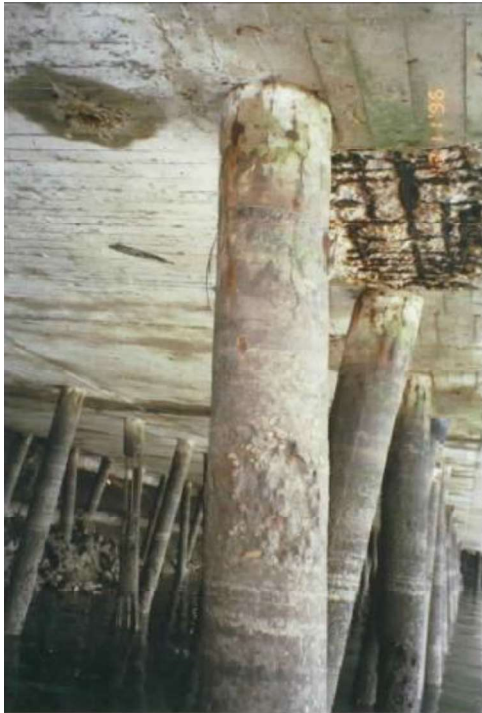
Foto 3 – Pormenores de estacas e laje
