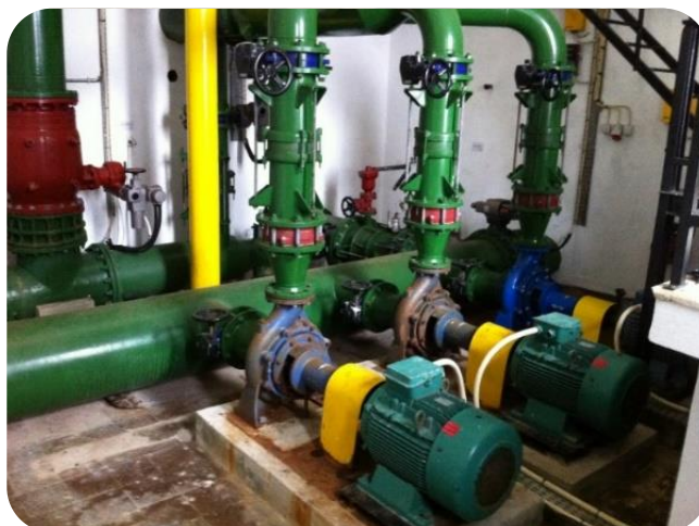
Figura 16 - Fotografia geral da estação de Gémeos.
