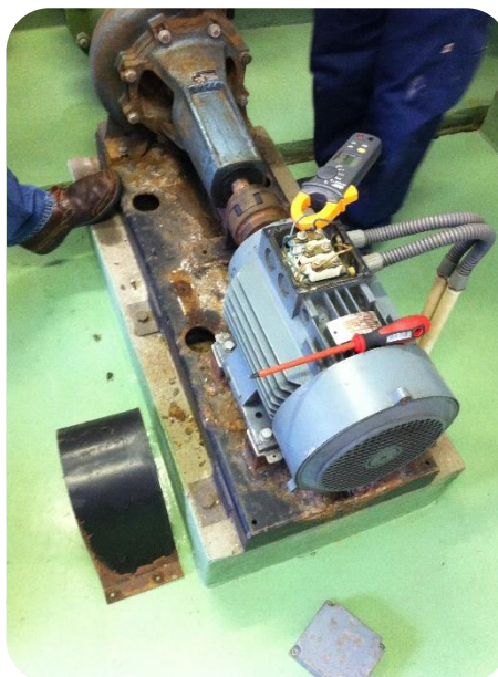
Figura 36 - Recolha de corrente elétrica em cada fase do motor da eletrobomba 1.
