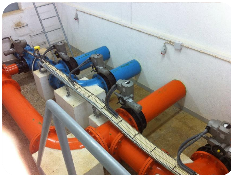
Figura 24 - Fotografia geral da estação de Linhó.
