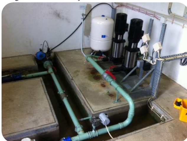
Figura 12 - Instalações da estação de Olelas.
