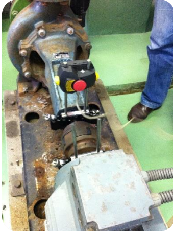
Figura 33 - Início da montagem do sistema de verificação do alinhamento de veios.
