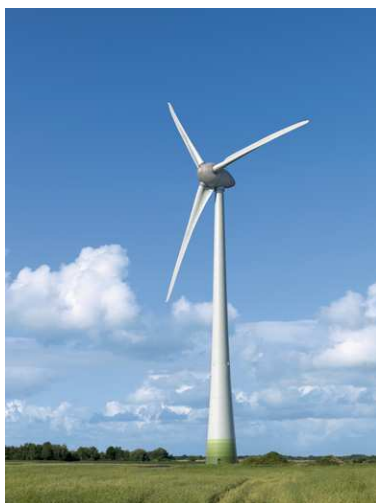
Figura 4.13 – Torre eólica Enercon-126
