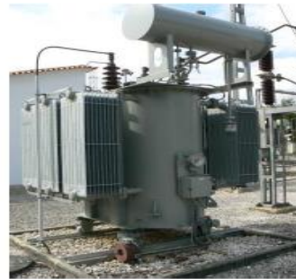
Figura 2. 16 - Diagrama do autotransformador de tração [16]. Figura 2. 17 - Autotransformador de tração [17].
