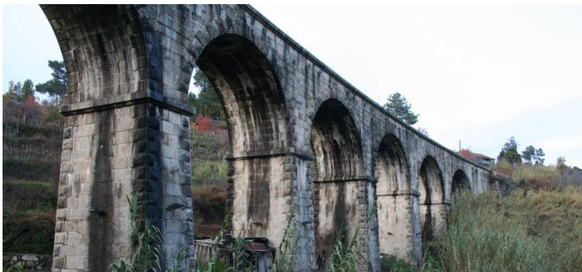
Figura 6.1 – Viaduto da Flandres
