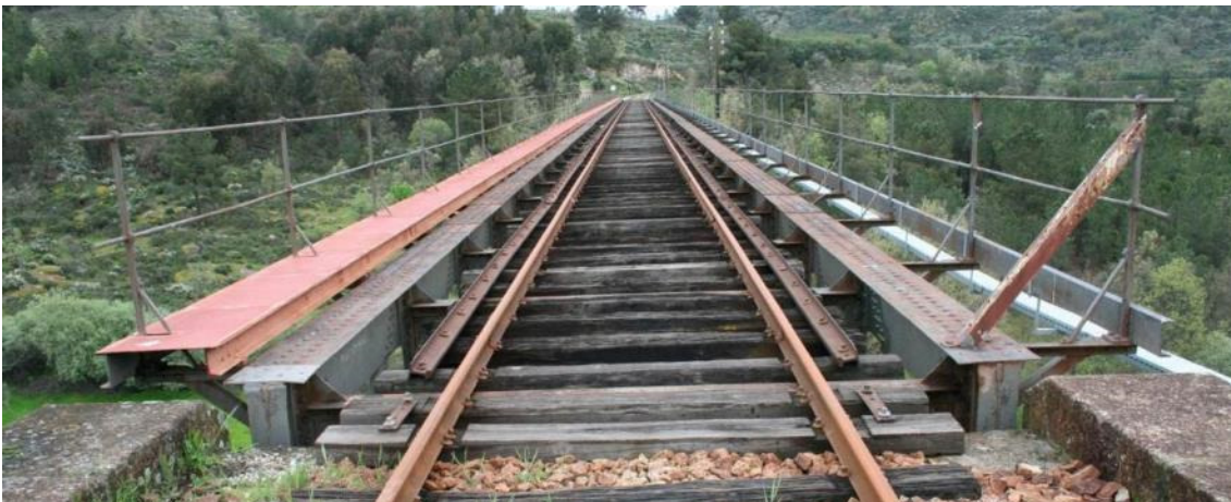
Figura 6.17 – Ponte de Maçainhas - Tabuleiro
