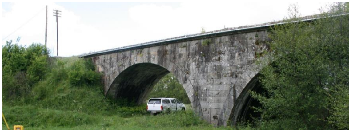
Figura 6.44 – Ponte de Noémi
