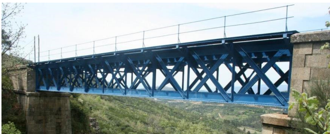
Figura 6.28 – Ponte da Tapada das Côrtes
