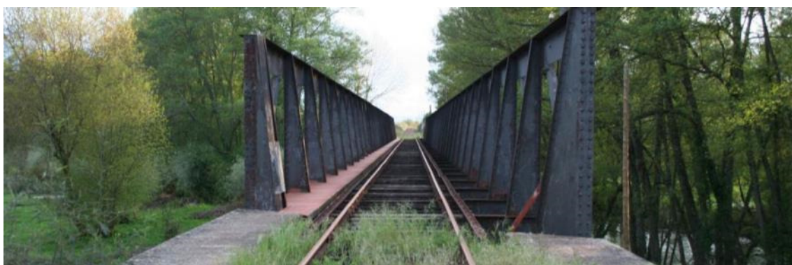
Figura 6.13 – Ponte do Zêzere II - Tabuleiro
