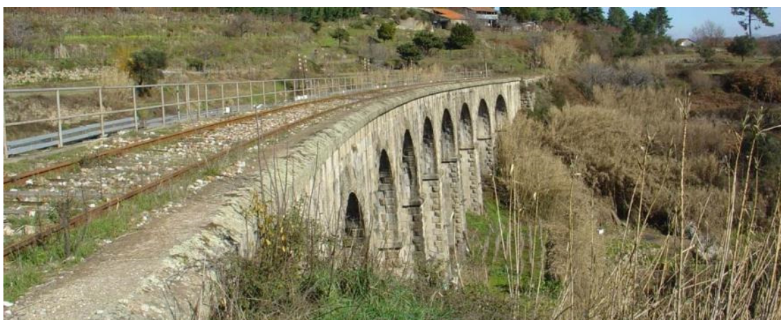
Figura 6.2 – Viaduto da Flandres - Tabuleiro
