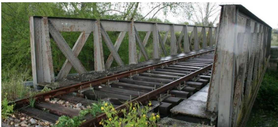
Figura 6.50 – Ponte do Rio Diz
