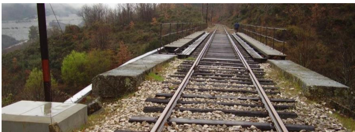
Figura 6.41 – Ponte de Silveiras I - Tabuleiro
