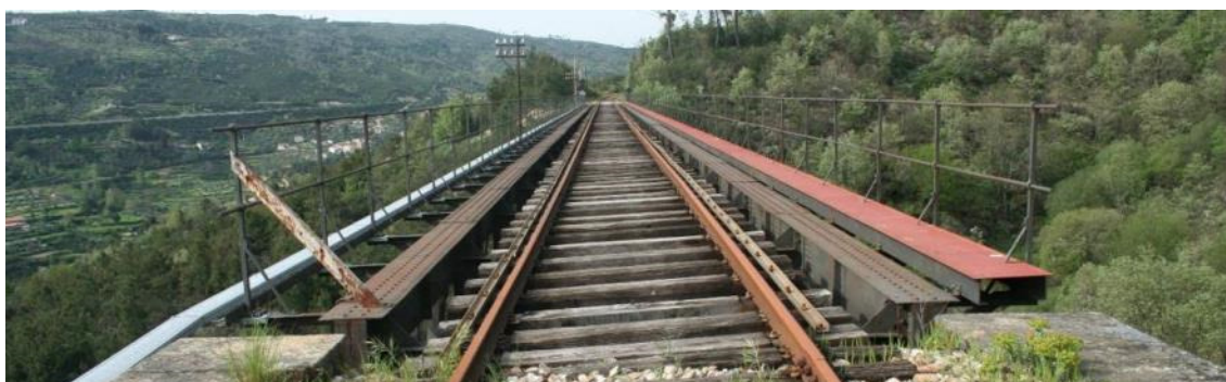
Figura 6.37 – Ponte da Penha da Barroca - Tabuleiro
