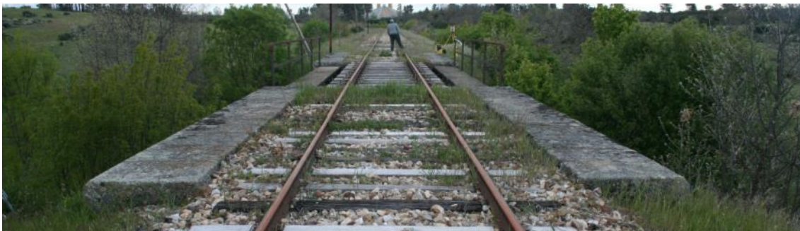
Figura 6.48 – Ponte de Corte de Cavalos - Tabuleiro
