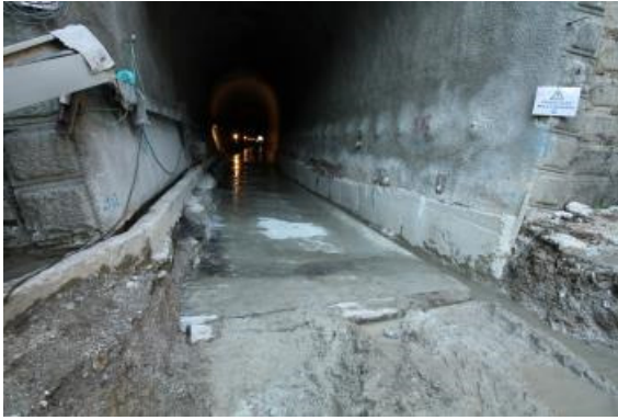
Figura 6.55 – Revestimento – Boca Sul
