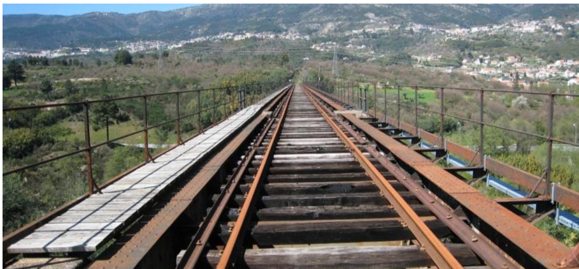
Figura 6.8 – Ponte do Corge - Tabuleiro
