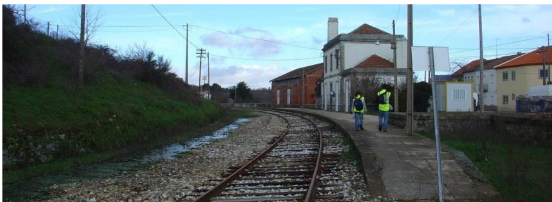
Figura 5.3 – Apeadeiro de Barracão / Sabugal
