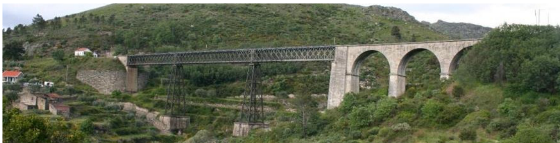
Figura 6.20 – Ponte dos Gogos
