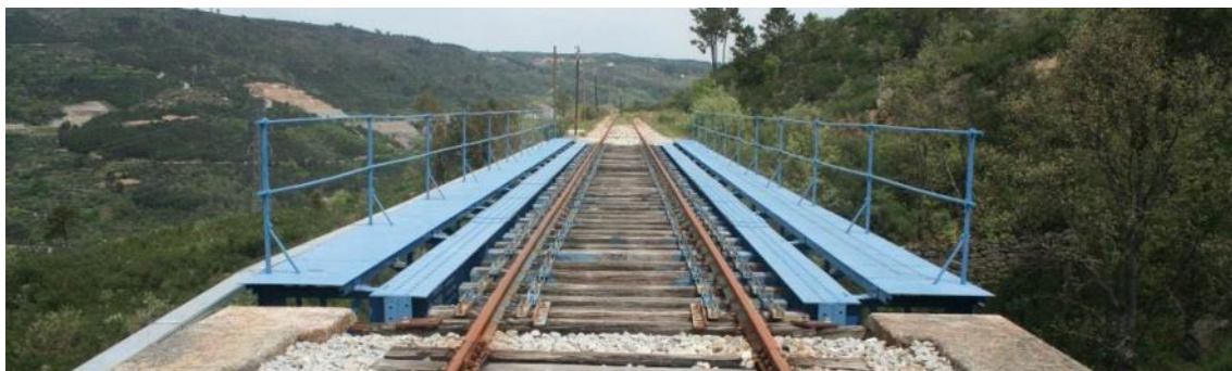
Figura 6.29 – Ponte da Tapada das Côrtes - Tabuleiro
