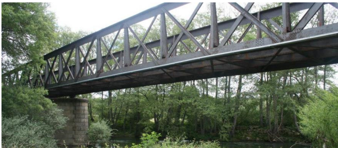
Figura 6.12 – Ponte do Zêzere II
