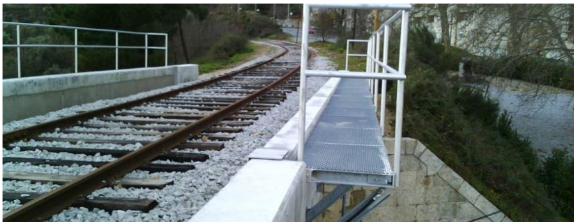
Figura 6.5 – PI da Baiúca - Tabuleiro
