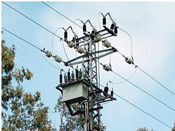
Figura 4.5 – Disjuntores Auto-Religadores (DAR)
