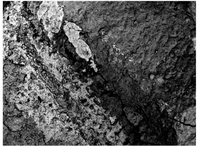
Micrografia da superfície betão adjacente à armadura obtida em modo ER
