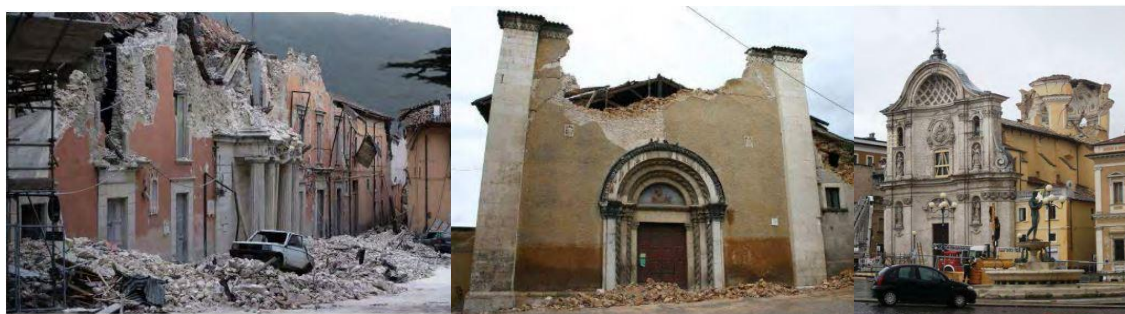
Figura 2.22 Danos em alguns edifícios de alvenaria no centro histórico de L'Aquila (Romão et al., sem data)
