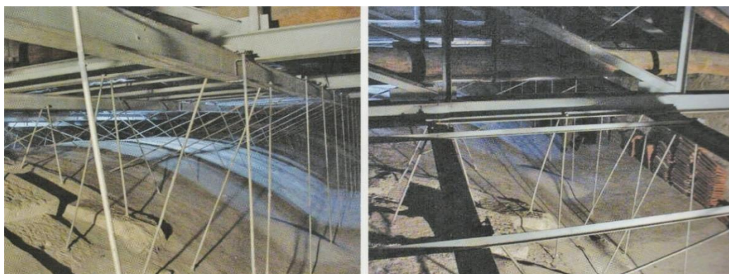
Figura 3.5 Reforço dos arcos e colocação de tirantes nos contrafortes, adaptado de (Paisana dos Santos Lopes et al., 2008)
