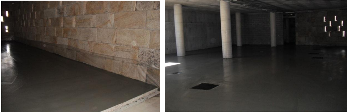
Figura 3.46 - Betonagem do acabamento final
