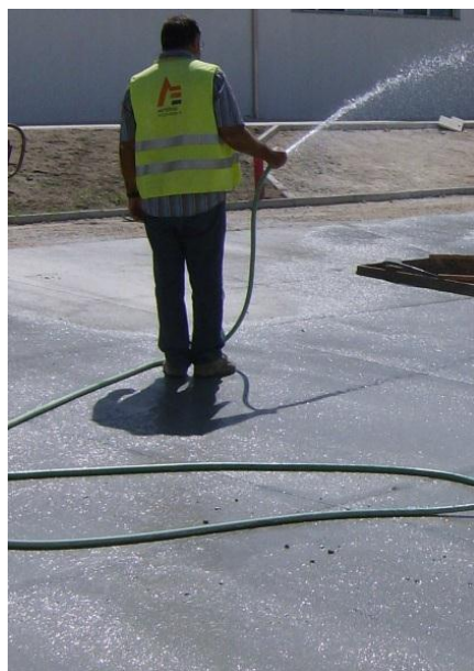
Figura 3.35 - Rega das superfícies betonadas
