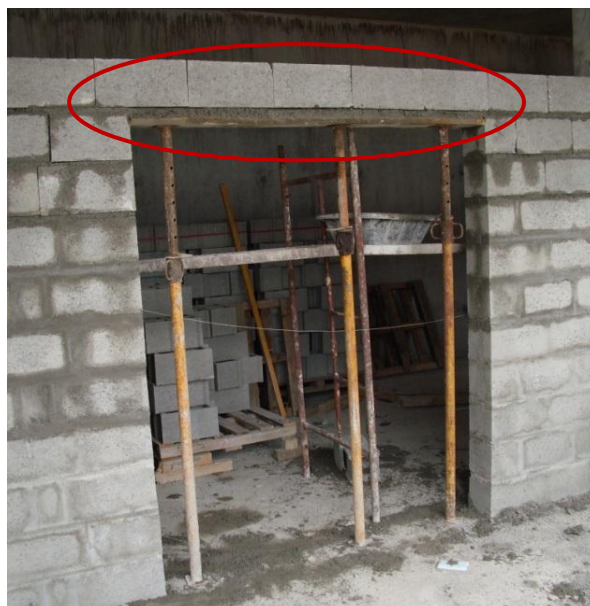
Figura 3.45 - Escoramento para porta
