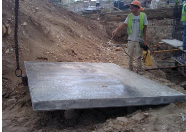
Figura 3.11 - Aplicação de óleo descofrante
