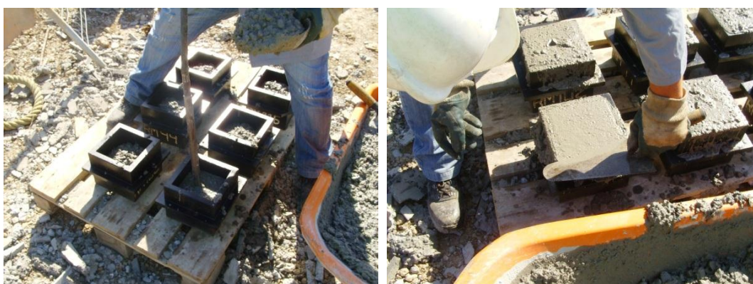
Figura 3.6 - Recolha dos provetes cúbicos para o ensaio de compressão ao betão
