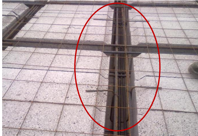
Figura 3.26 - Pormenor do espaçador e da armadura superior entre os blocos
