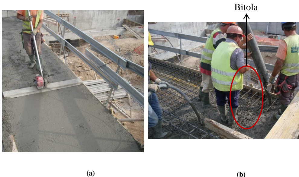
Figura 3.34 - Compactação da consola (a) e betonagem da consola (b)
