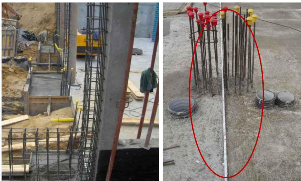
Figura 3.29 - Execução da junta de dilatação
