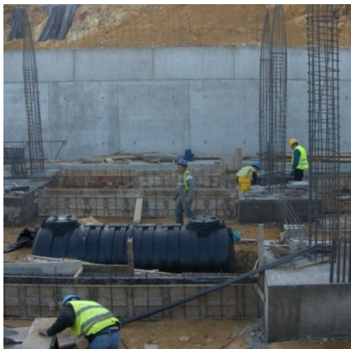
Figura 3.53 - Instalação de depósito de águas residuais
