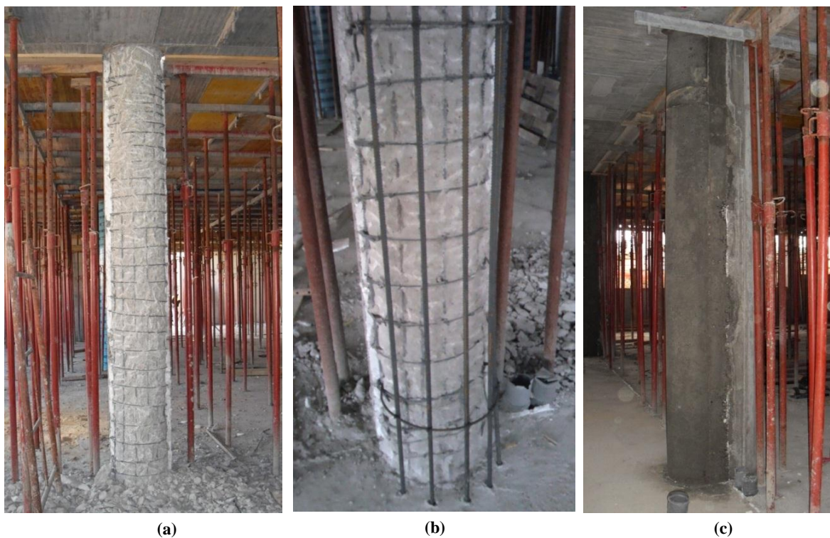
Figura 3.40 - Execução do reforço dos pilares
