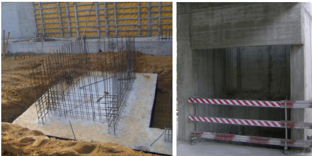
Figura 3.21 - Armaduras em espera para as paredes do núcleo e núcleo executado
