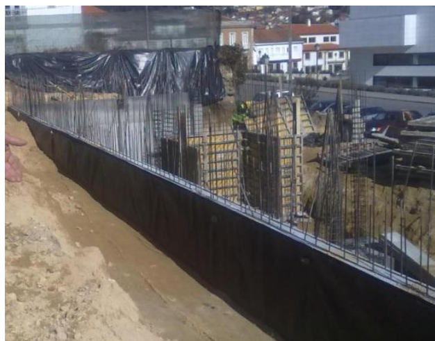
Figura 3.14 - Armaduras em espera para ligação à laje ou ao restante muro
