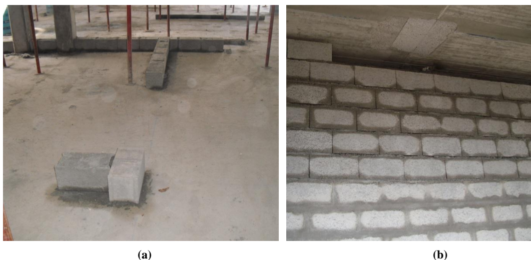
Figura 3.44 - Colocação da primeira fiada (a) e execução da ligação da última fiada à laje (b)
