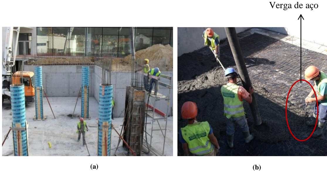
Figura 3.33 - Betonagem do pilar (a) e pavimento térreo (b)
