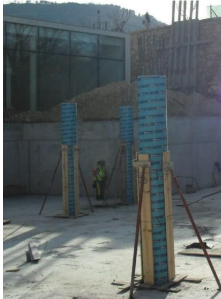
Figura 3.20 - Cofragem de pilar escorada
