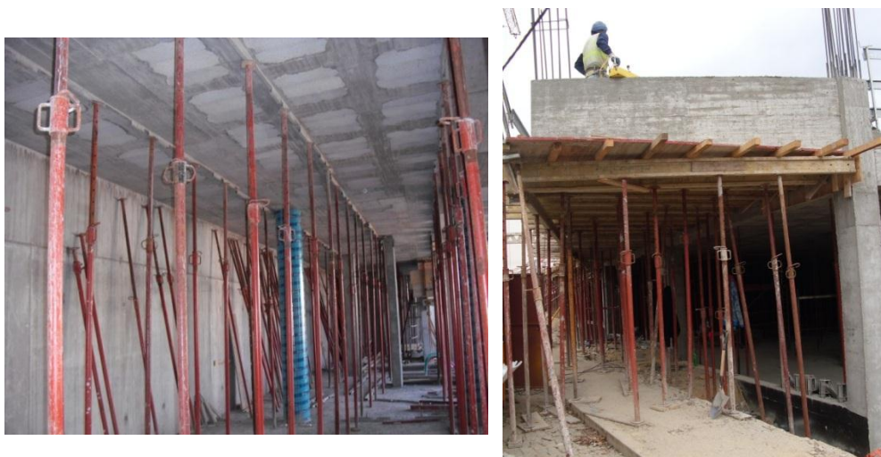
Figura 3.38 - Laje escorada e consola com os moldes inferiores escorados
