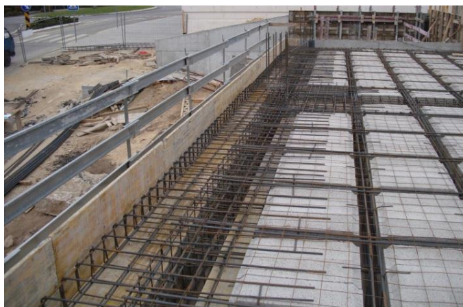
Figura 3.28 - Pormenor da viga de bordadura pronta a betonar
