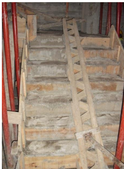
Figura 3.31 - Aspeto da escada um dia após a betonagem
