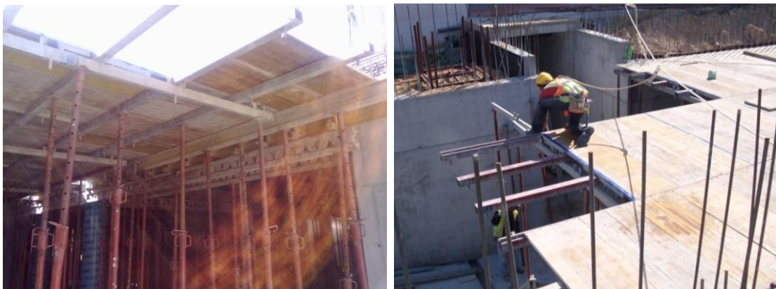
Figura 3.23 - Cofragem da laje
