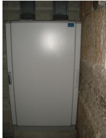
Figura 3.48 - Quadro geral do edifício
