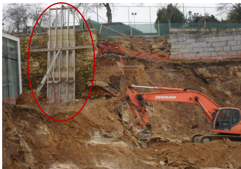
Figura 3.1 - Escavação do terreno e escoramento
