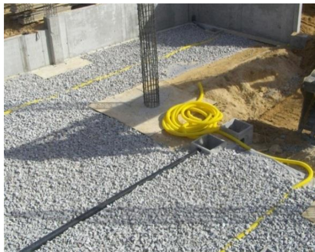
Figura 3.16 - Instalação do sistema de drenagem
