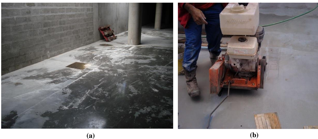
Figura 3.47 - Aspeto final do pavimento (a) e criação da junta de retração (b)
