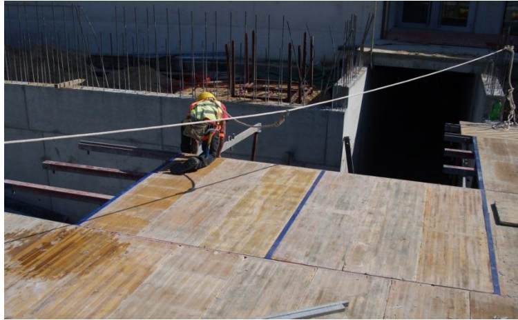
Figura 3.60 - Utilização de arnês de segurança durante a execução da cofragem da laje
