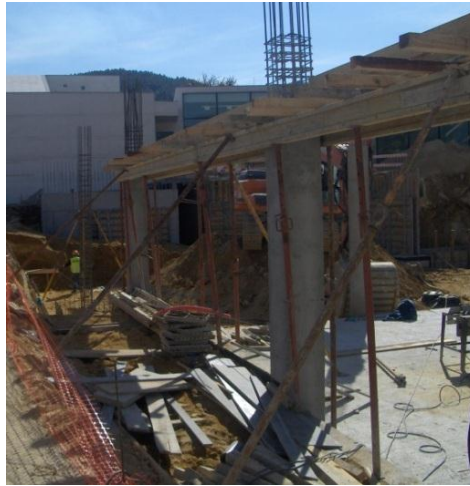
Figura 3.22 - Cofragem da viga
