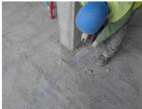
Figura 3.43 - Marcação da parede com fio itálico
