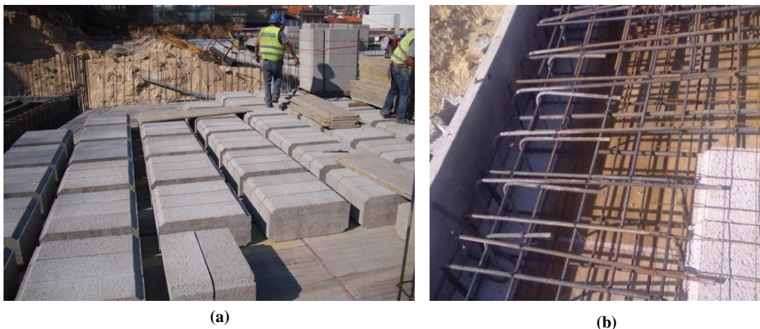
Figura 3.25 - Colocação dos blocos (a) e execução do empalme entre a laje e o muro de suporte (b)
