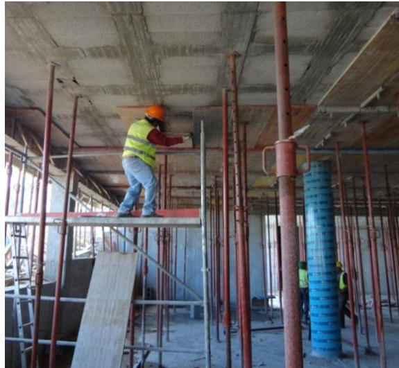
Figura 3.37 - Desmoldagem da cofragem da face inferior da laje
