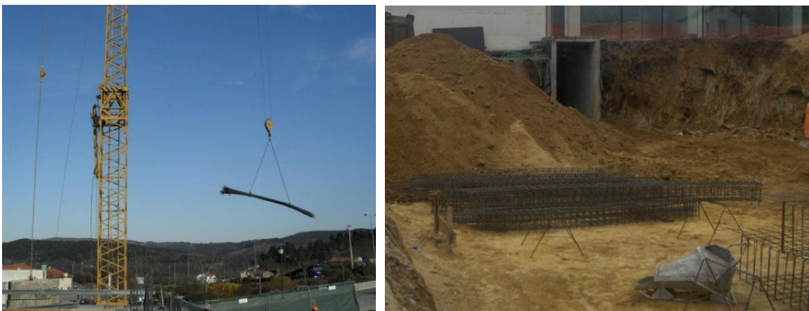
Figura 3.9 - Estaleiro: Movimentação e armazenamento de elementos da armadura da estrutura
