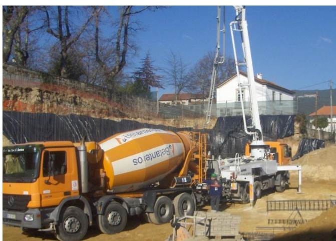
Figura 3.32 - Camião betoneira juntamente com o camião bomba
