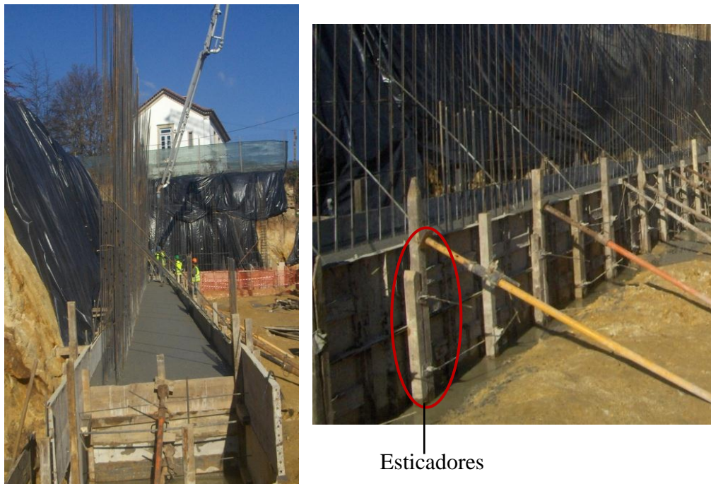
Figura 3.10 - Sistema de cofragem e escoramento das sapatas do muro de suporte
