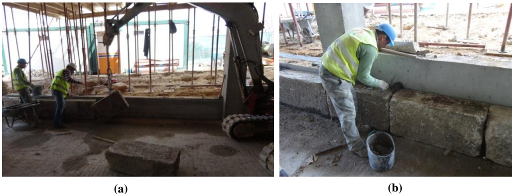
Figura 3.41 - Colocação da pedra no respetivo local (a) e selagem das juntas com argamassa (b)
