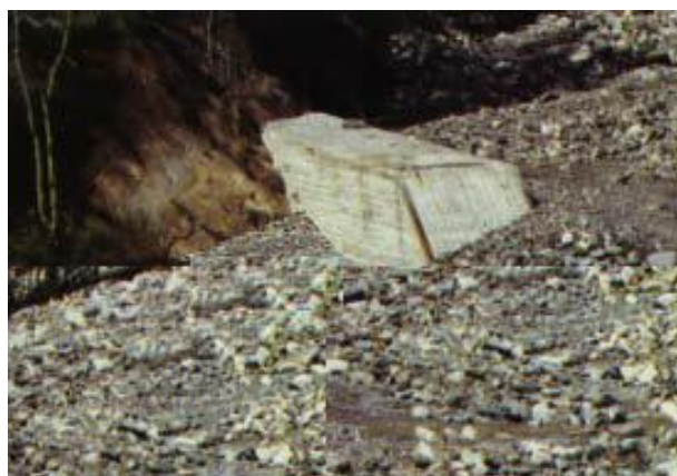
Figura 48 - Esporão em betão
