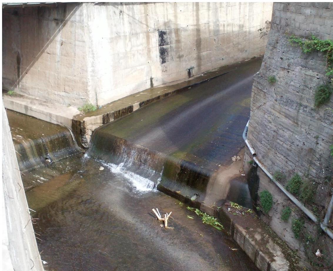
Figura 52 - Revestimento do fundo e das margens da ribeira do Vigário
