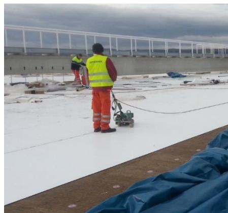
Imagem 42 - Trabalhador soldando a sobreposição das membranas
