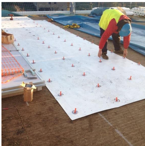
Imagem 31 - Aplicação do molde e dos acessórios de fixação
