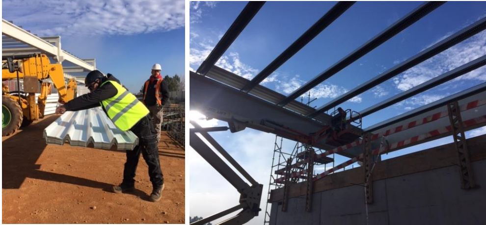
Imagem 7 - Demonstração de fixação de chapa com trabalhador
