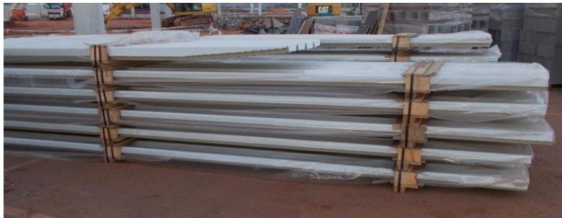
Imagem 8 - Malotes de chapas de cobertura
