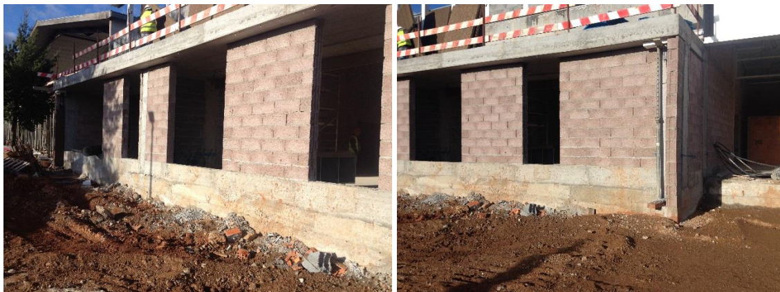
Imagem 43 - Tosco da fachada a revestir com compósito de alumínio
