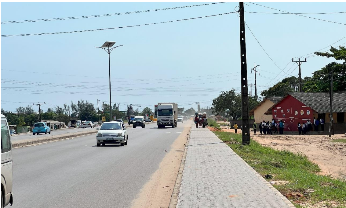
Figura 5-8 Passeio construído entre o km 1+210 ao 1+640 (sentido decrescente).
