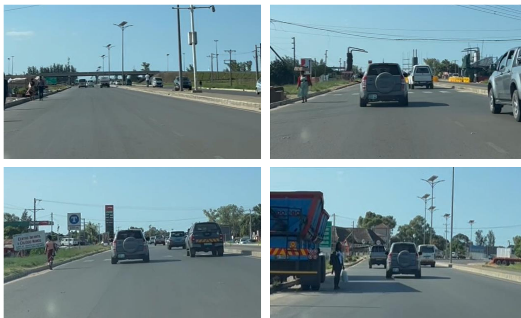
Figura 5-44 Circulação de peões devido a ausência de percursos pedonais.
