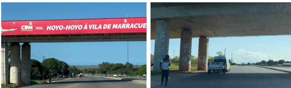
Figura 5-51 Pilares da Obra de Arte do Nó de Zimpeto.
