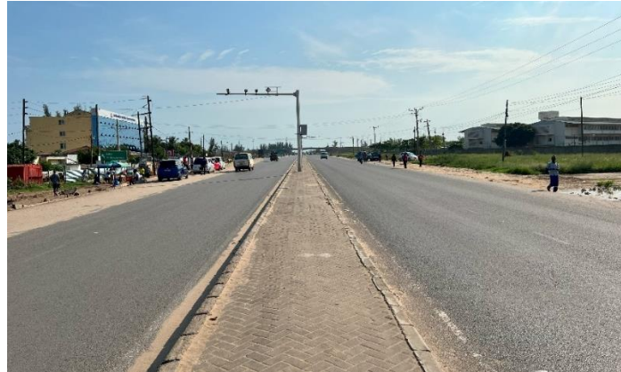
Figura 5-4 Vista ao km 0+000 para o troço em estudo (sentido crescente da quilometragem).
