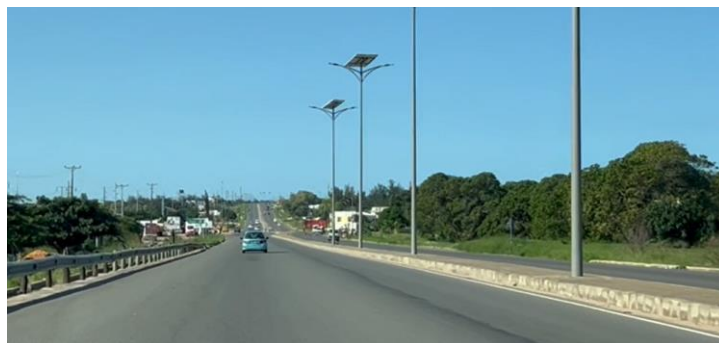
Figura 5-19 Vista ao km 10+700 (sentido crescente).
