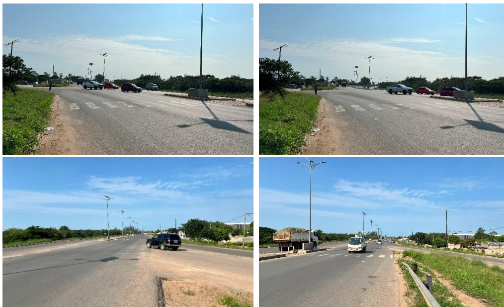
Figura 5-37 Vista ao km 5+540.
