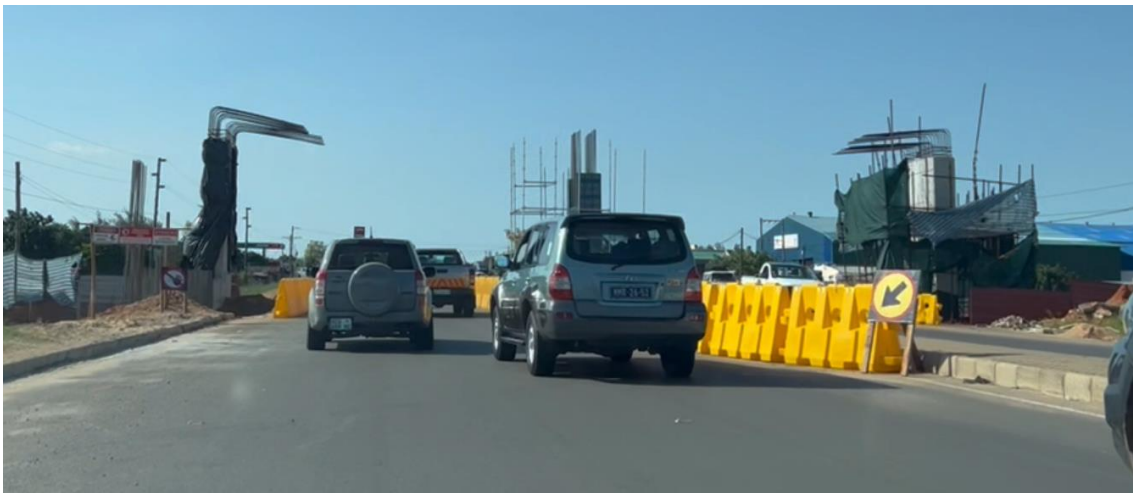
Figura 5-7 Vista ao km 1+640 na zona das obras de construção da PSP (sentido crescente).
