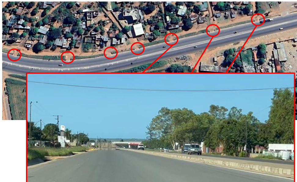
Figura 5-22 Vista ao km 13+900 (sentido crescente).
