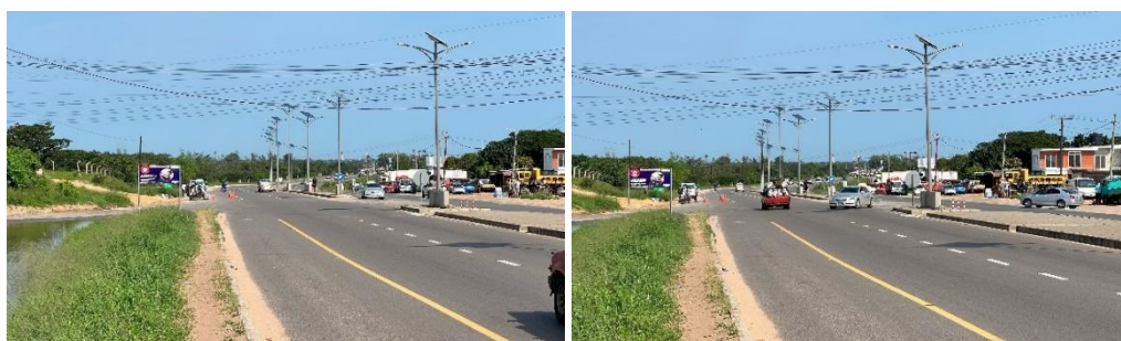
Figura 5-38 Vista ao km 5+720.
