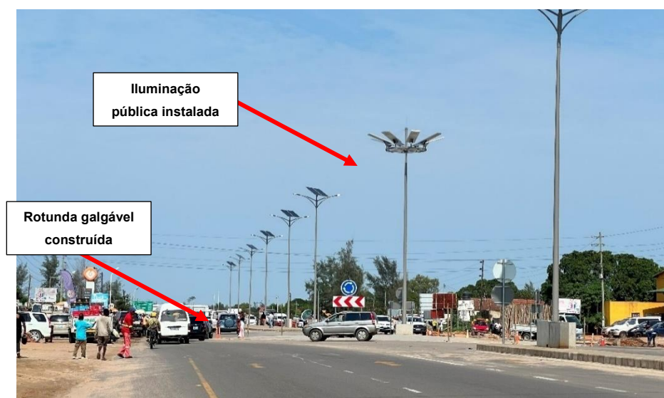
Figura 5-12 Troço em intervenção para melhoria da SR (vista ao km 3+580).
