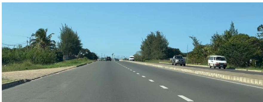
Figura 5-15 Vista ao km 6+720 (sentido crescente).
