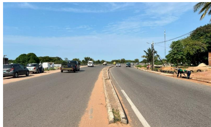
Figura 5-5 Vista ao km 15+500 para o troço em estudo (sentido decrescente).
