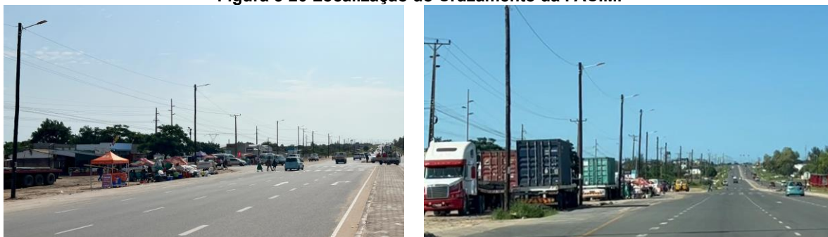
Figura 5-21 Vista ao km 11+200 (sentido crescente).
