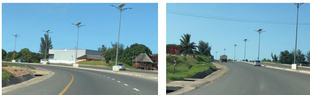
Figura 5-54 Valeta interrompida por acessos irregulares.
