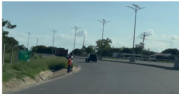
Figura 5-50 Zona de transição entre escavação e aterro.
