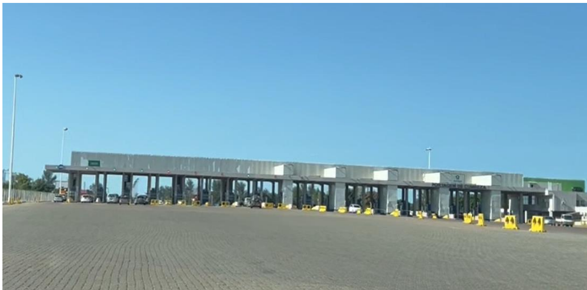
Figura 5-9 Vista ao km 2+440 na área da Praça de Portagem de Cumbeza (sentido crescente).
