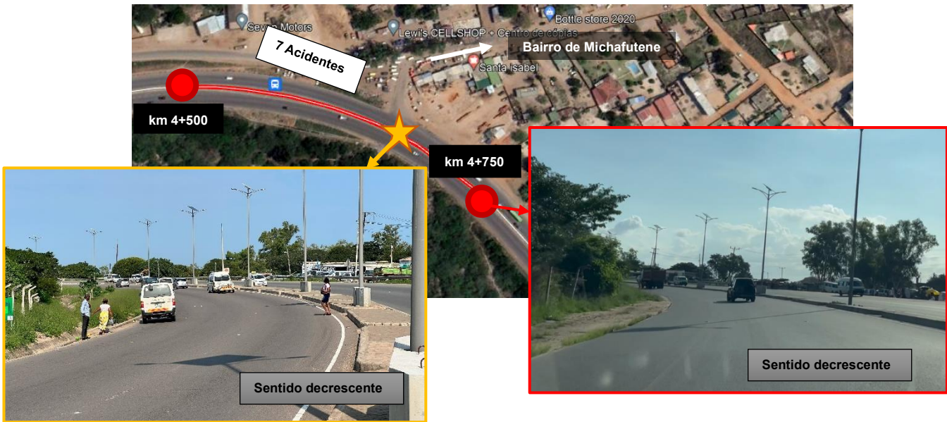
Figura 5-31 Localização e vistas da secção entre km 4+500 e 4+750.
