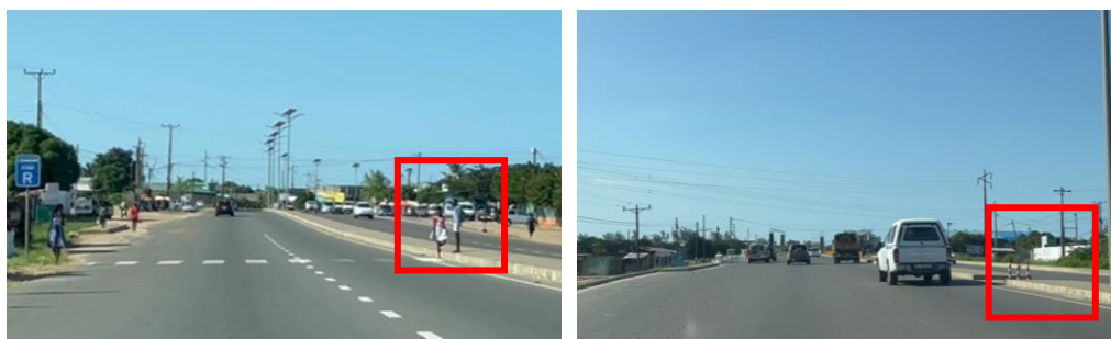
Figura 5-46 Problemas de acessibilidade e sinalização em travessias.
