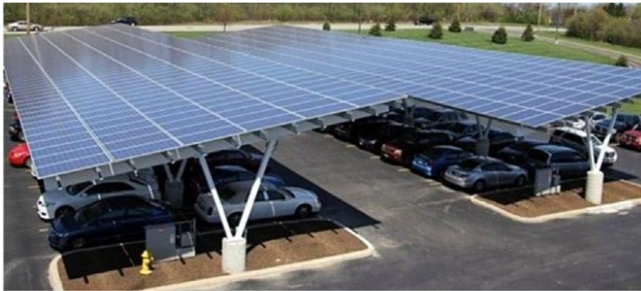
Figura 8 - Estrutura carport solar implementado em parque de estacionamento com filas duplas cobertas
