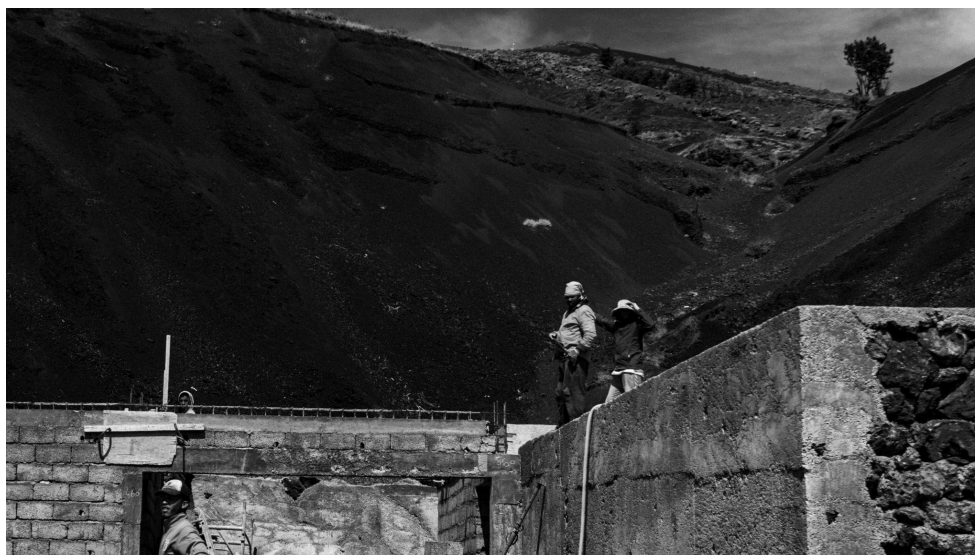
Figura n.º 13 Construção de uma casa na aldeia da Chã das Caldeiras.
