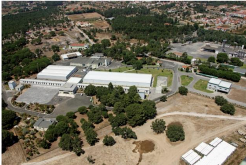
Figura 17 – Fotografia aérea da ETA de Vale da Pedra (Águas de Portugal, 2016b)
