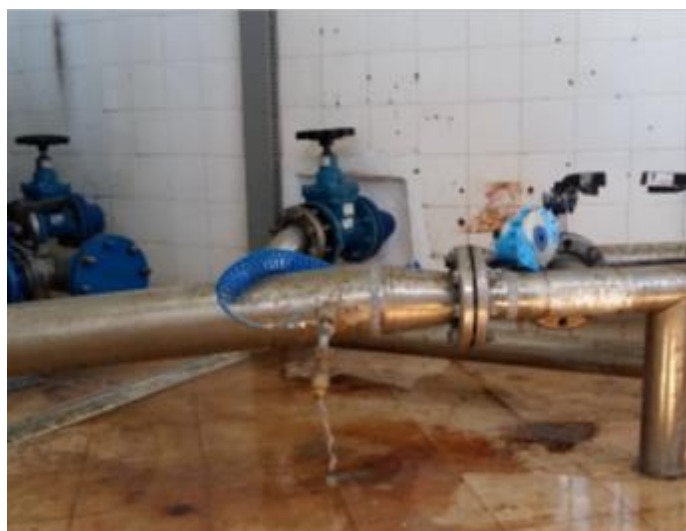
Figura 37 – Medidor de caudal e pressão instalado à saída do reservatório
