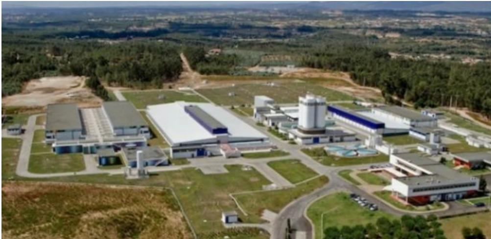
Figura 14 – Fotografia aérea da ETA da Assêiceira (Águas de Portugal, 2016a)
