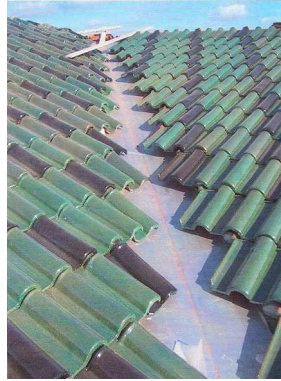
Fig. 8.4.4. Execução de laró
