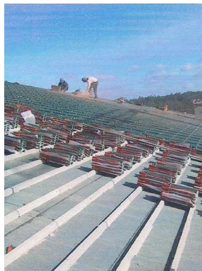
Fig. 8.4.1. Assentamento de telha
