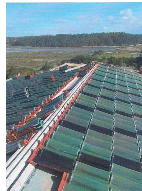
Fig. 8.4.2. Execução de cumeeira
