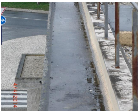
Figura 39 - Tela Betuminosa na Cobertura, RL
