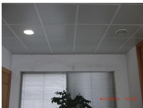
Figura 8 - Entrada principal (tetos)
