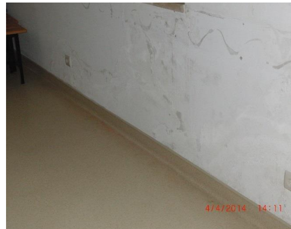
Figura 20 - Pavimento Vinílico, RL
