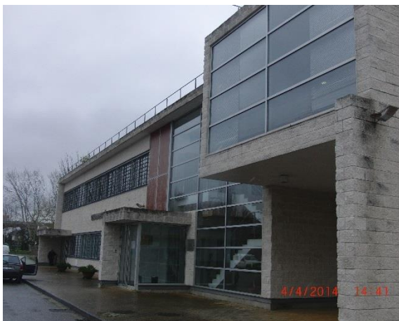
Figura 7 - Fachada Principal, RL
