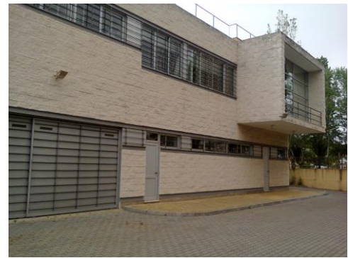
Figura 16 - Fachada de tardoz
