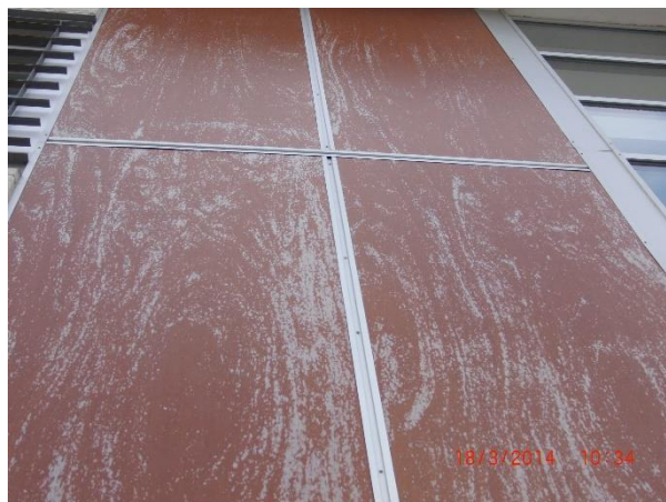
Figura 10 - Painéis fenólicos fachada principal
