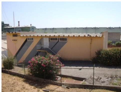
Fig. 7 – Reservatório em Santa Iria de Azóia ZB
