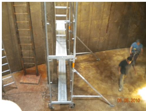
Fig. 85 – Plataforma de trabalho elevado (1 torre andaime) [17]
