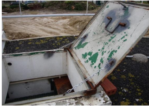
Fig. 54 - Tamba de acesso ao interior de um reservatório
