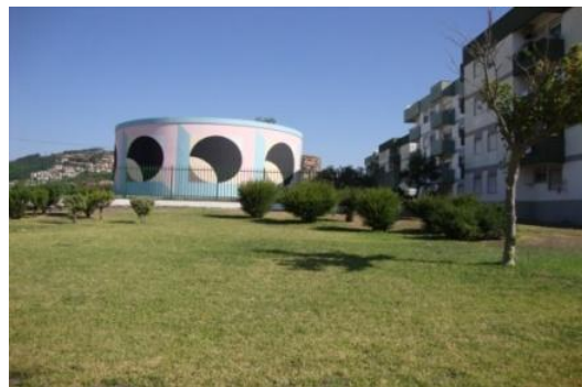
Fig. 2 – Reservatório na Arroja
