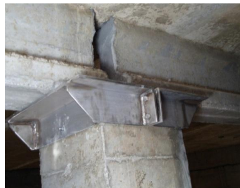
Fig. 78 - Pilar superior do reservatório de Santo António dos Cavaleiros, após reabilitação [17]
