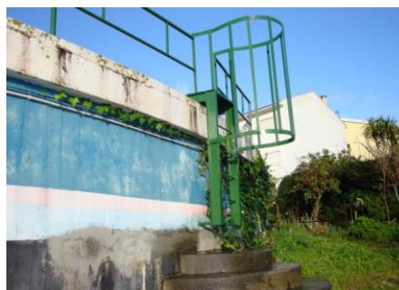
Fig. 53 - Escada de acesso à cobertura e elemento de protecção na laje da cobertura
