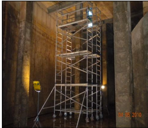
Fig. 84 – Plataforma de trabalho elevado (2 torres de andaimes) [17]
