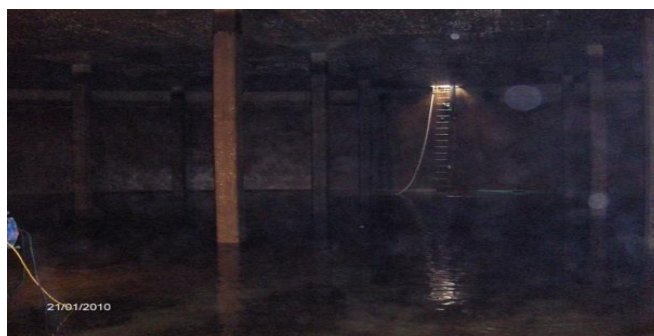
Fig. 70 – Interior do reservatório da Portela
