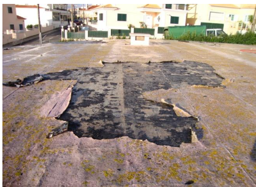
Fig. 16 - Impermeabilização da laje de cobertura
