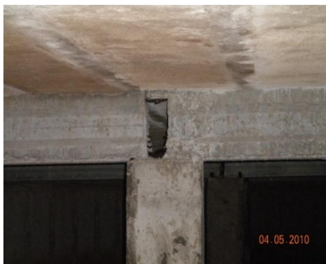
Fig. 77 – Pilar superior do reservatório de Sto. António dos Cavaleiros [17]
