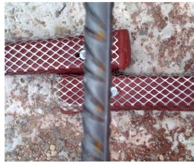
Fig. 34 – Instalação de junta em bentonite de sódio no reservatório em Pintéus
