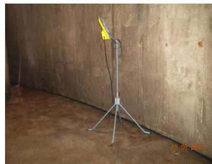
Fig. 81 - Pórtico de iluminação [17]
