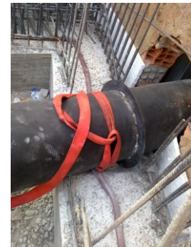
Fig. 35 - Instalação de junta em bentonite de sódio no reservatório em Pintéus
