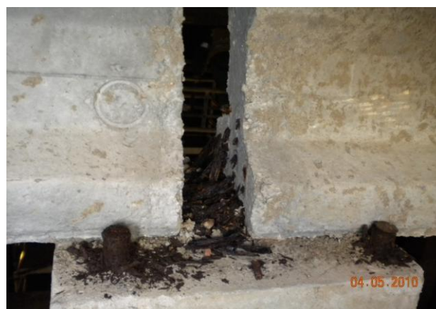
Fig. 89 - Vigas de betão pré-esforçado, assente em pilar [17]
