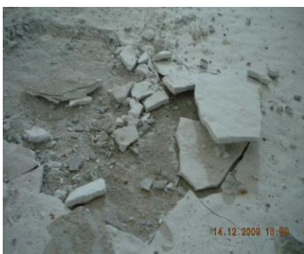
Fig. 57 - Laje de fundo
