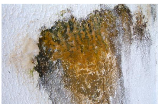
Fig. 47 - Parede com colonização biológica
