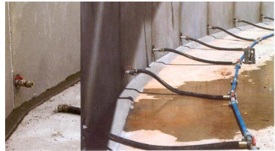
Fig. 31 – Processo de injeção das juntas verticais [22]
