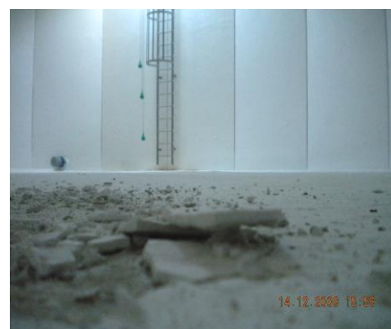
Fig. 58 – Laje de fundo
