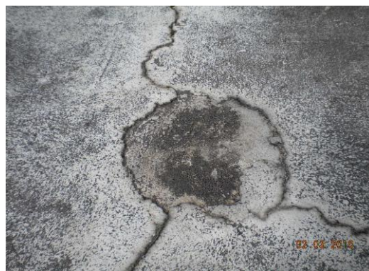
Fig. 17 - Impermeabilização da laje de cobertura
