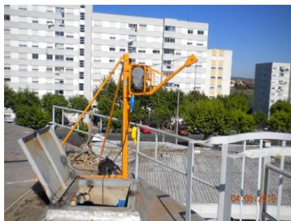
Fig. 80 – Guincho de elevação de materiais e equipamentos [17]
