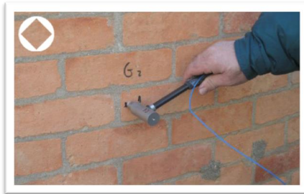
Figura 4.11 – Ensaio de Ultra-sons (Fonte: Scielo Portugal)
