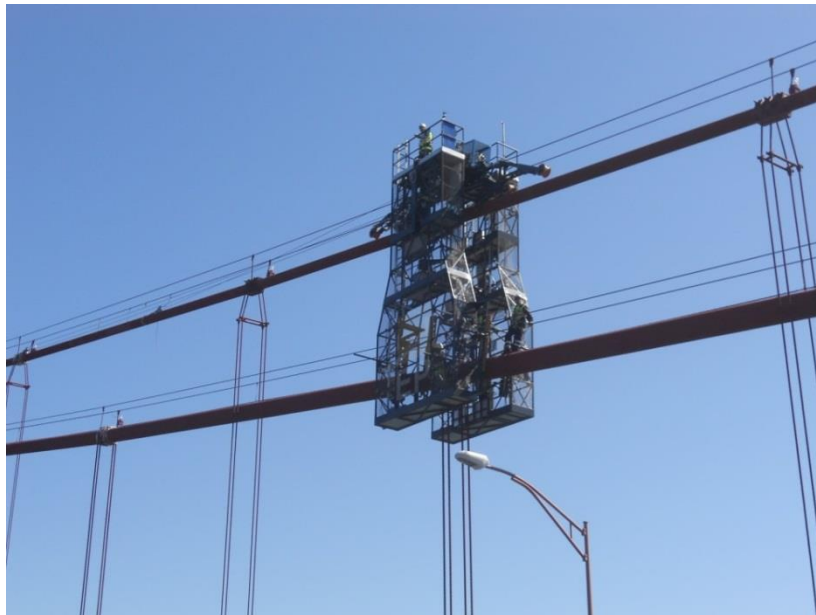
Figura 44 - Obras de manutenção da Ponte 25 de Abril (parte 1). [ http://blogcatim.blogspot.pt/2013/06/plataforma-inovadora-para-manutencao-na.html ]
