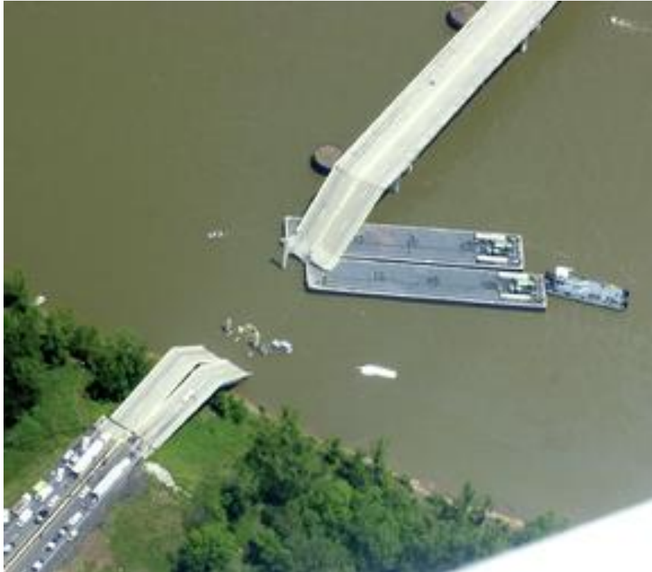
Figura 4 – Colapso da ponte I-40 em Oklahoma (2002).
