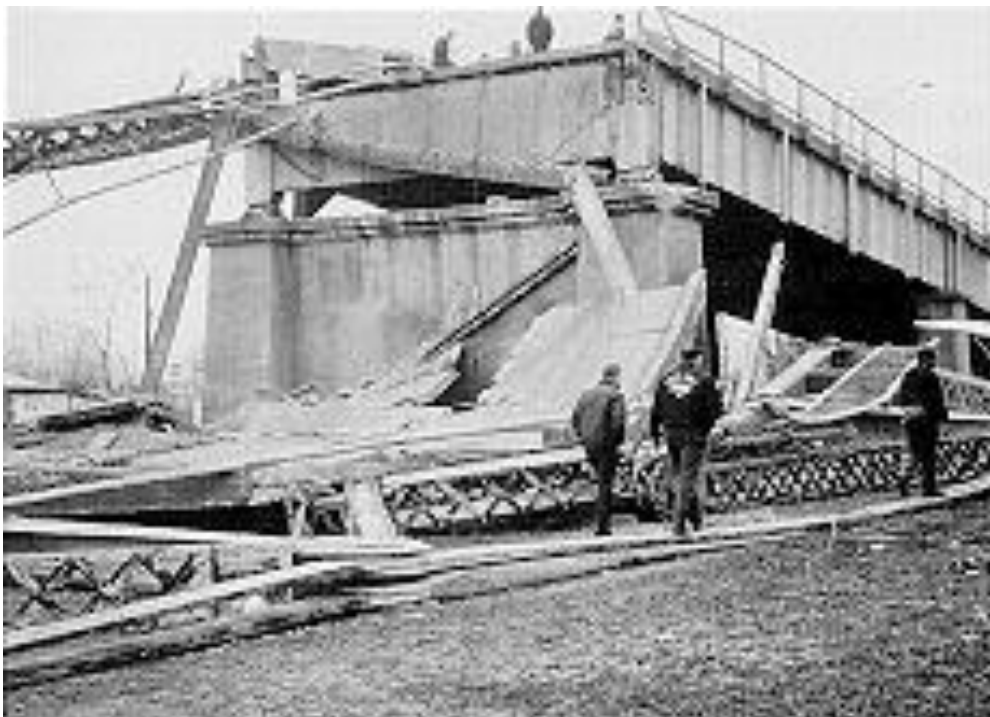
Figura 1 - Colapso da ponte Silver (1967). [3]
