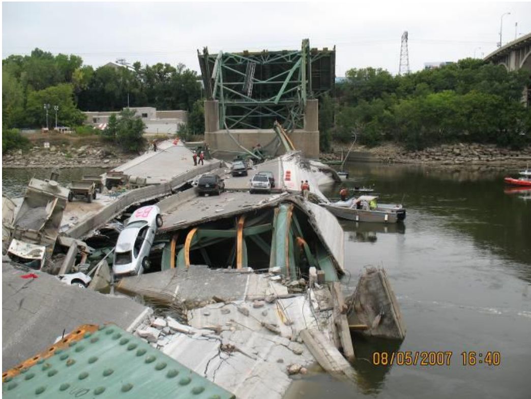
Figura 10 - Imagem do colapso da ponte I-35W. [5]
