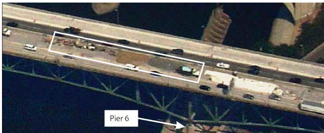
Figura 23 - Obras no dia do colapso da ponte I-35W. [6]
