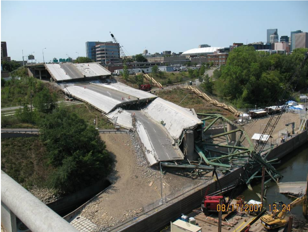
Figura 18 – Colapso da zona Sul da ponte I-35W. [5]
