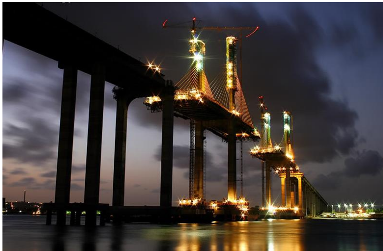
Figura 43 - Construção da Newton Navarro Bridge , Brasil. [ http://www.skyscrapercity.com/showthread.php?t=463633 ]
