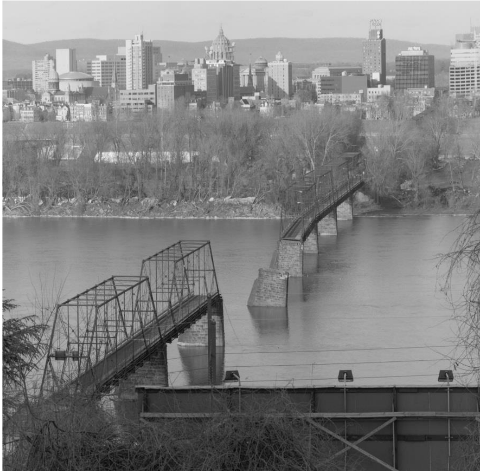
Figura 2 – Colapso da ponte Walnut Street (1996).
