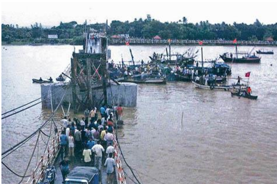
Figura 8 - Colapso da ponte Daman na India por falta de manutenção. (2003) [ http://lumq.com/01/collapse_of_bridges/ ]
