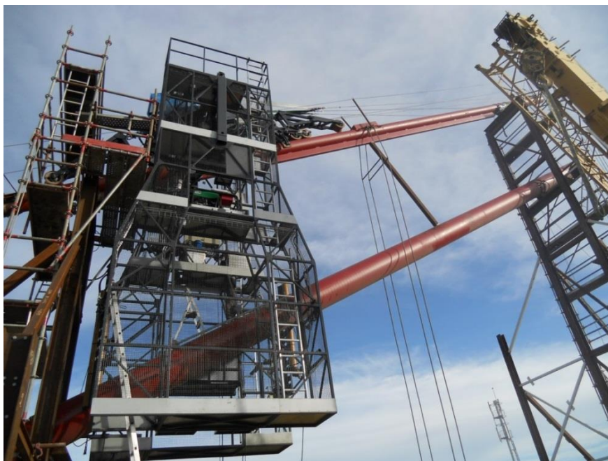
Figura 45 - Obras de manutenção da Ponte 25 de Abril (parte 2). [ http://blogcatim.blogspot.pt/2013/06/plataforma-inovadora-para-manutencao-na.html ]
