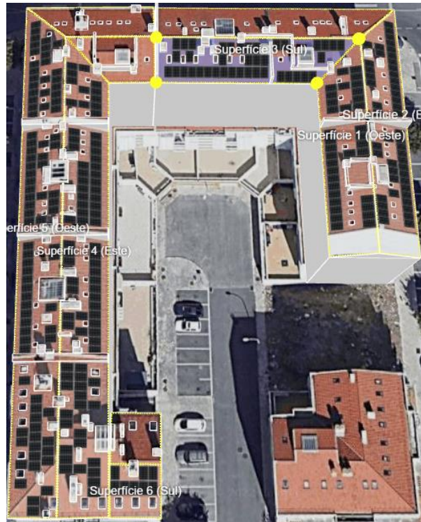
Figura 15 - Imagem final dos edifícios com painéis fotovoltaicos.
