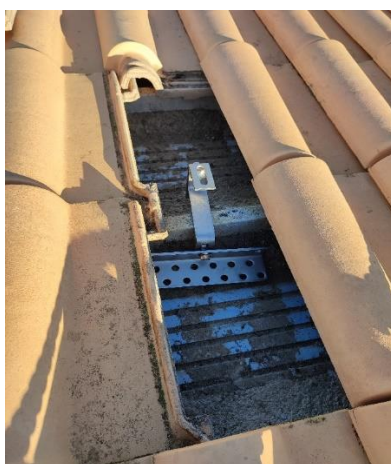
Figura 42 - Instalação em telhas de cerâmica.
