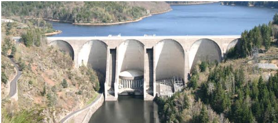
Figura 2.6 – Vista de jusante da barragem de Grandval, em Auvergne, França.
