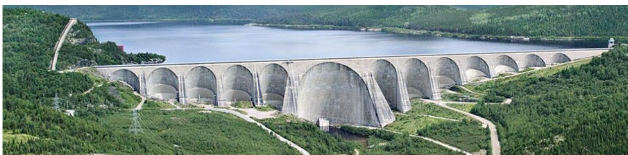
Figura 2.4 - Vista de jusante da barragem de Daniel Jonhson, na província do Québec, Canadá.
