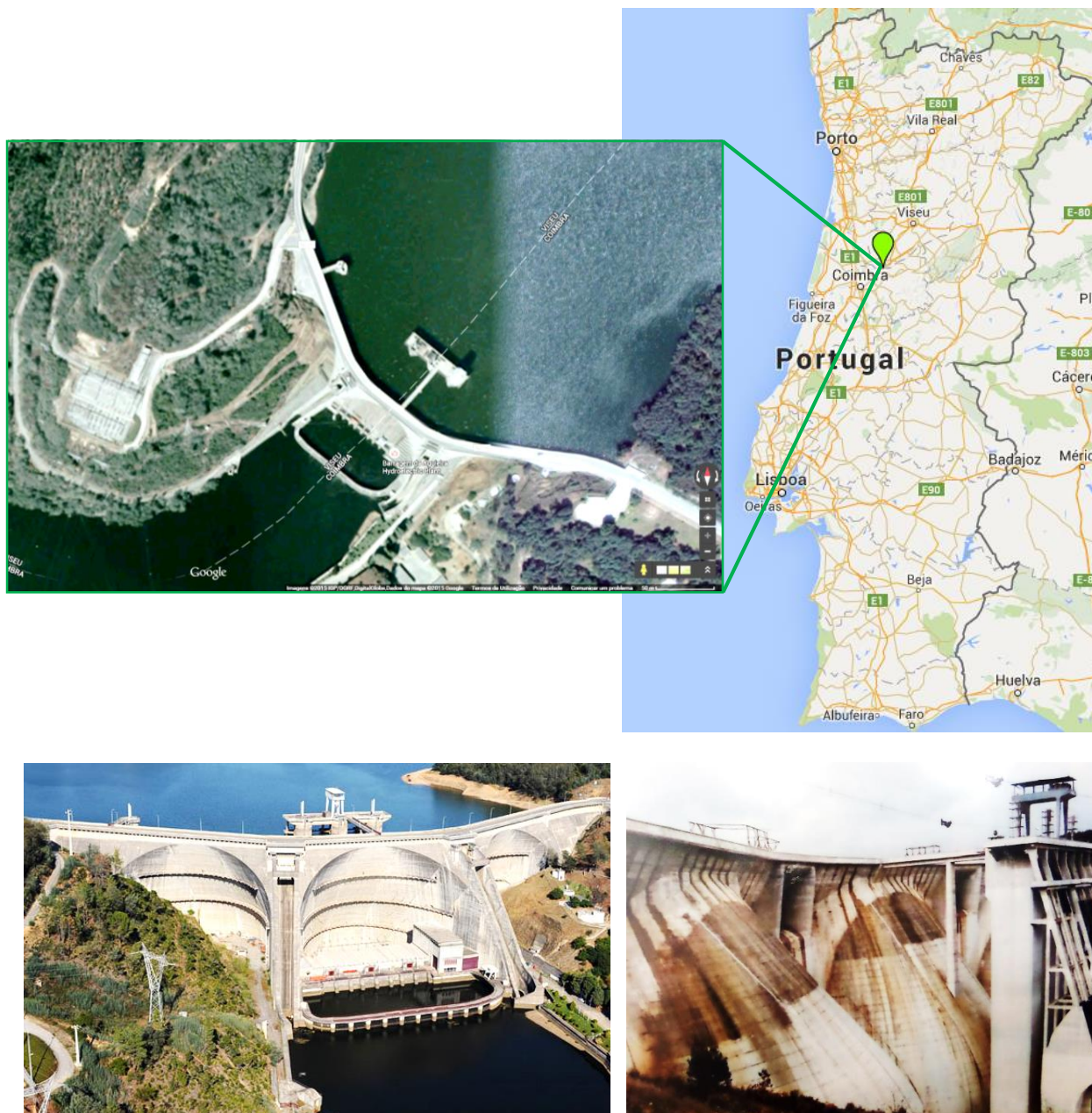
Figura 5.1 – Localização geográfica da barragem da Aguieira. Vista de jusante e vista de montante na situação de albufeira vazia, sendo visível a torre de tomada de água.
