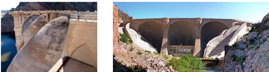
Figura 2.7 – Vista de montante e vista de jusante da barragem de Coolidge, no distrito de Gila/Pines, Estados Unidos da América.
