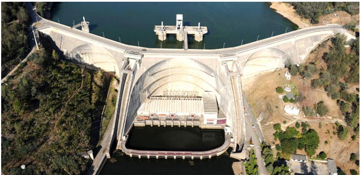
Figura 2.5 – Vista de jusante da barragem da Aguieira, Portugal.
